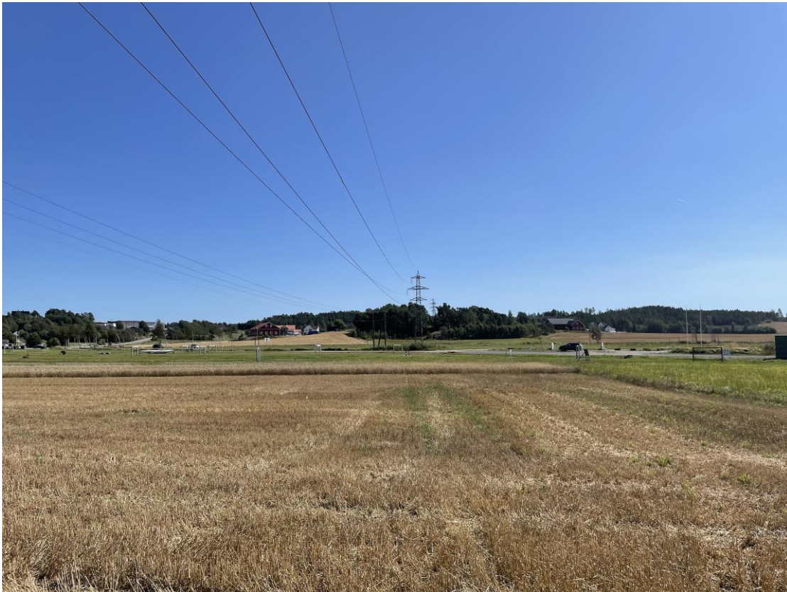
Figur 5-6. Bildet er tatt fra Fjørå transformatorstasjon østover mot Huseby. Eksisterende master på Fjørå-Skytterhuset som skal gjenbrukes vises midt i bildet.
