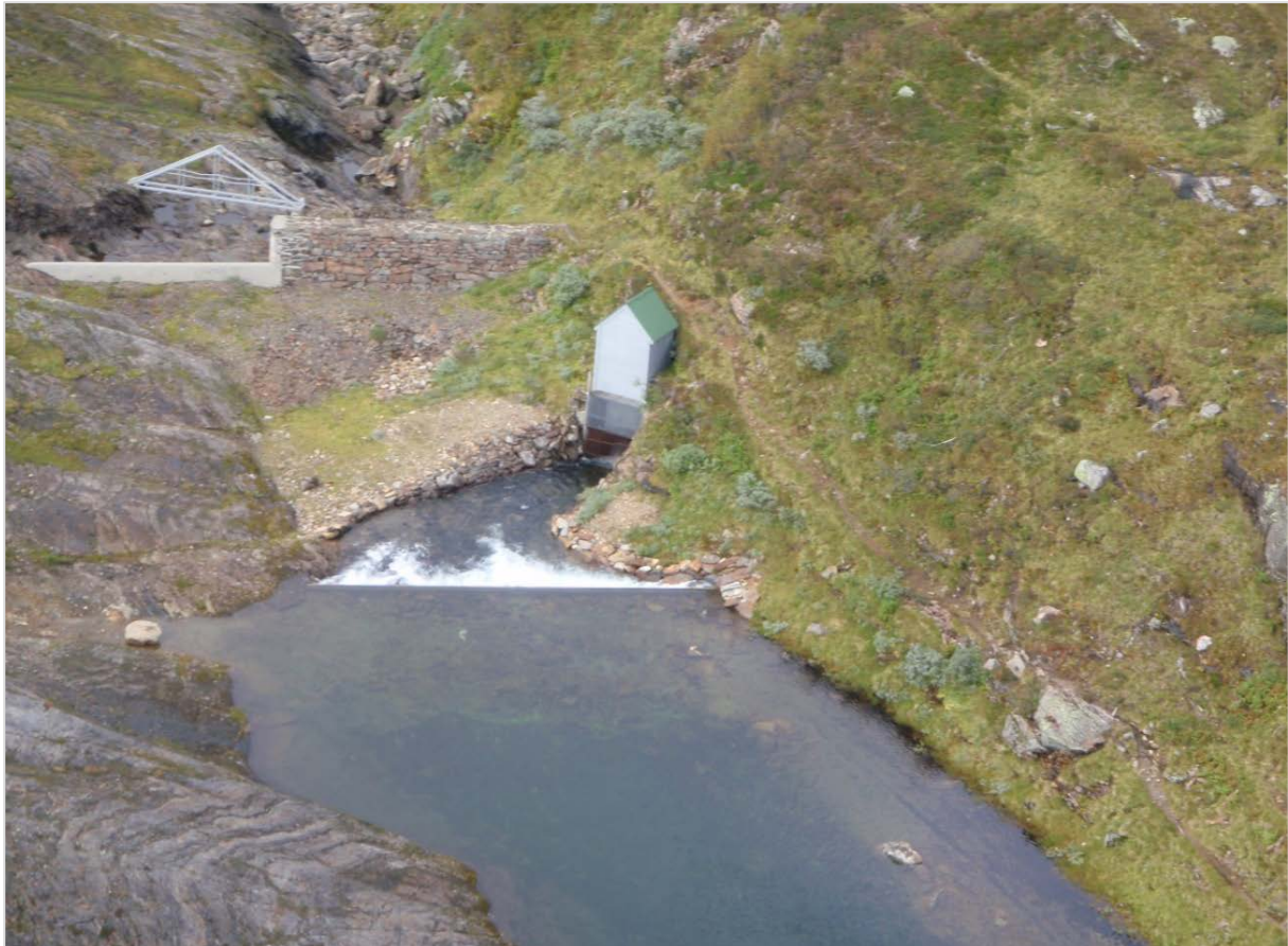
Figur 76 Dam Songrøvatnet, terskel og lukehus på overføring til Hamlagrøvatnet.
