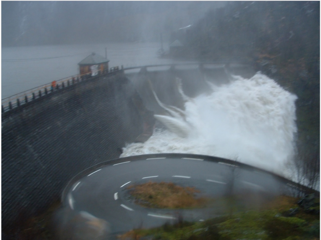
Figur 101 Overløp Storefossen 1,9 m. Flom 14.11.2005 (kl. 11.36).
