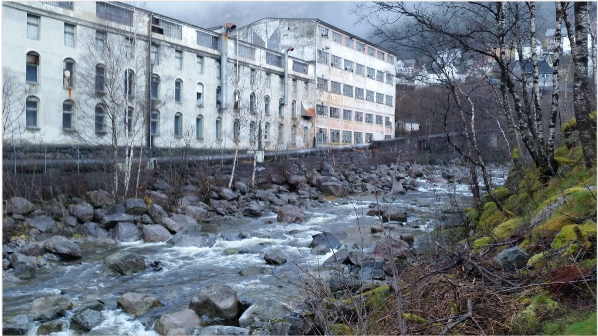
Figur 105 Daleelva langs Dale Fabrikker. Foto: 12.12.2014.
