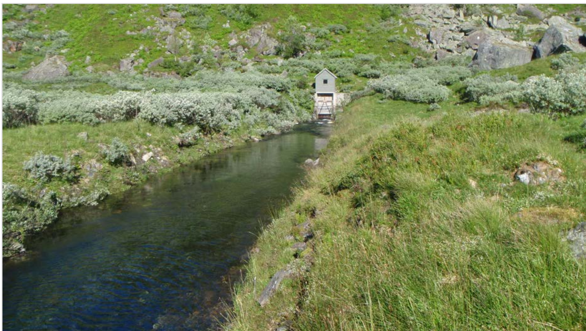
Figur 89 Kanal inn mot lukehus på overføring fra Breissettjørnet til Hamlagrøvatnet.
