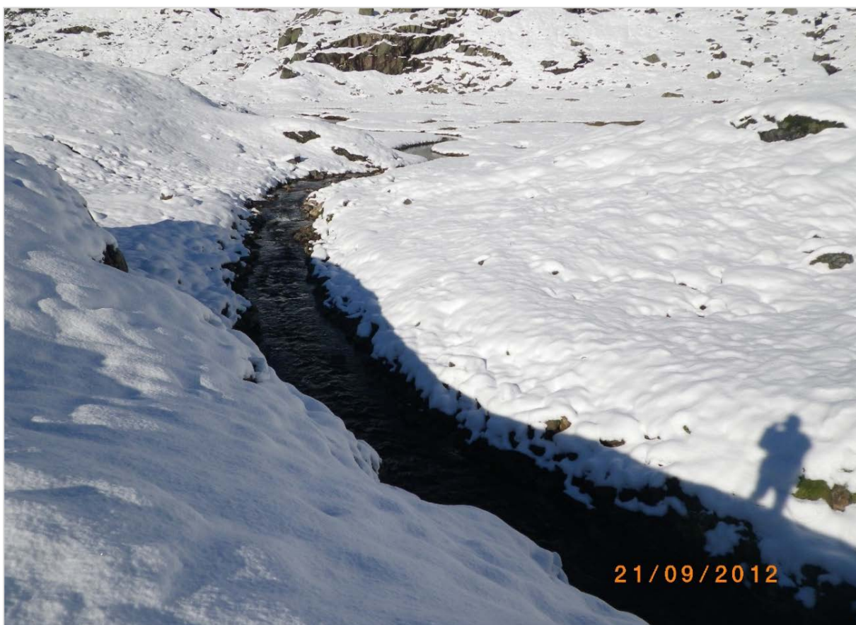
Figur 83 Kanal nedstrøms tunnel fra Løkjesdalstjørnane.
