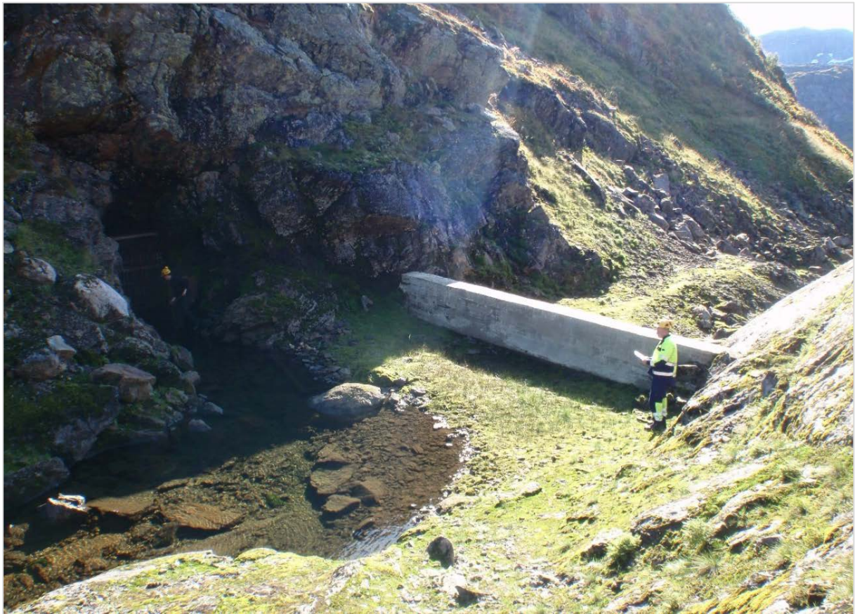
Figur 79 Sperredam og inntak Hardingskardet.
