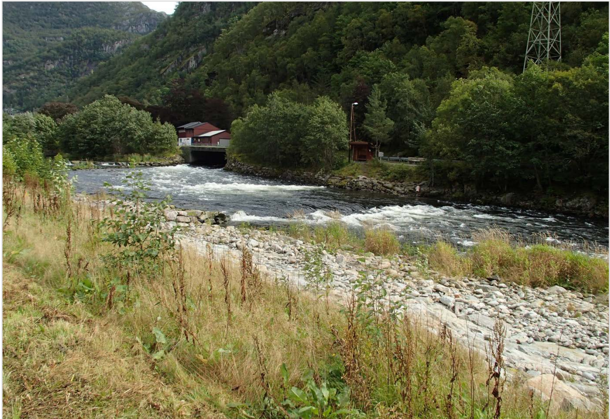
Figur 113 Utløpet av Dale kraftverk. Foto: 05.09.2016.
