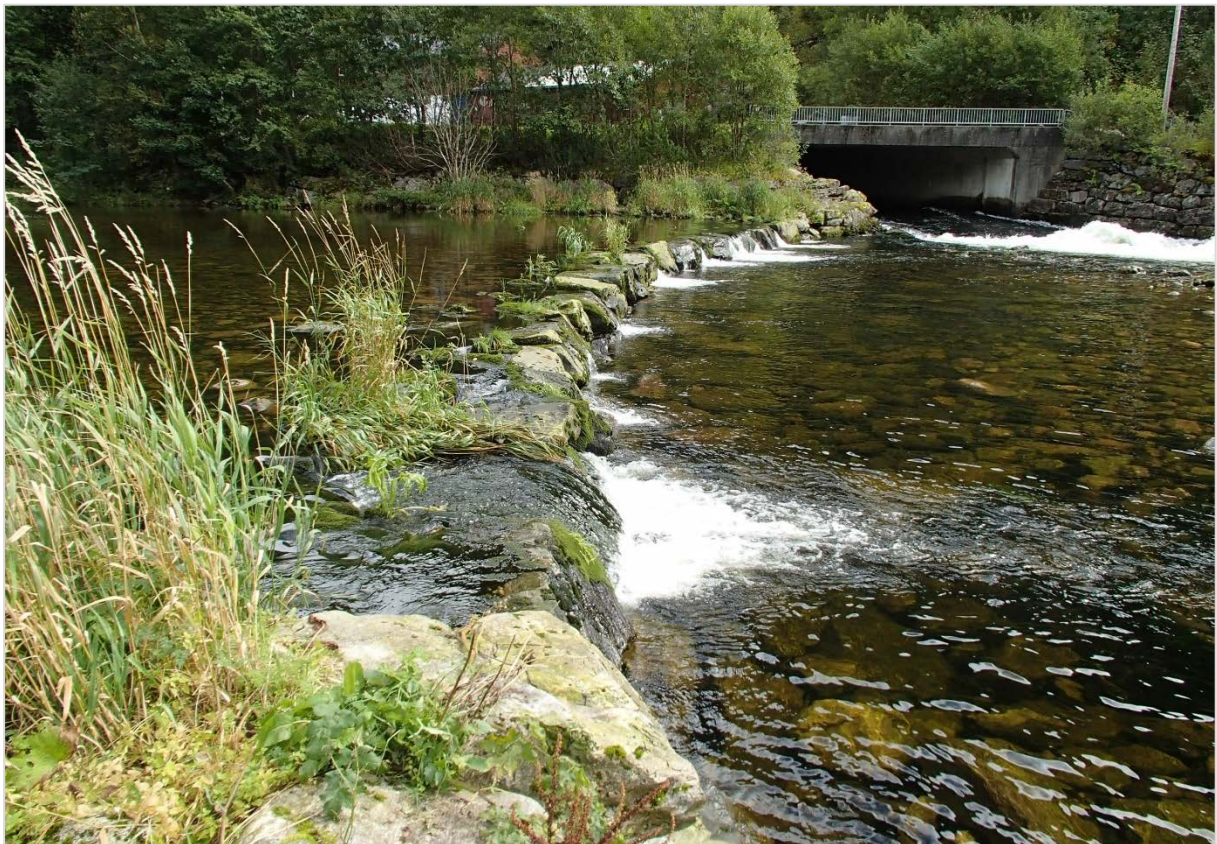
Figur 112 Utløpet av Dale kraftverk og terskel like oppstrøms utløpet. Foto: 05.09.2016.
