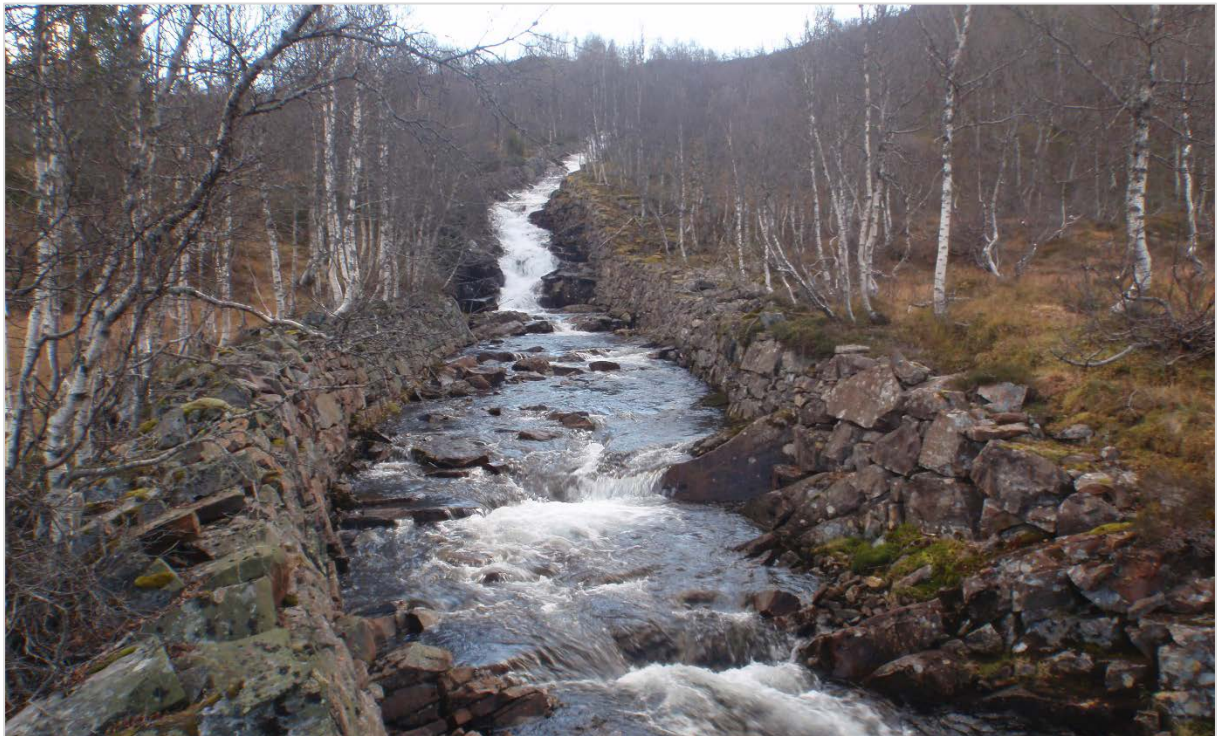
Figur 73 Kanal nedenfor lukehus/tunnel på overføringen fra Torfinnstjernet. Kaldestad kraftverk – Overføring fra Torfinnstjernet.
