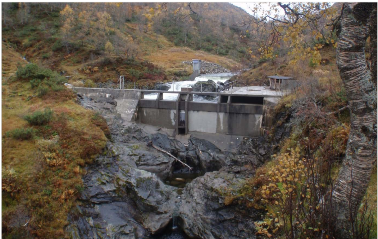
Figur 92 Inntaksdam Kaldåni. Målestasjon for vannføring ses i bakkant.
