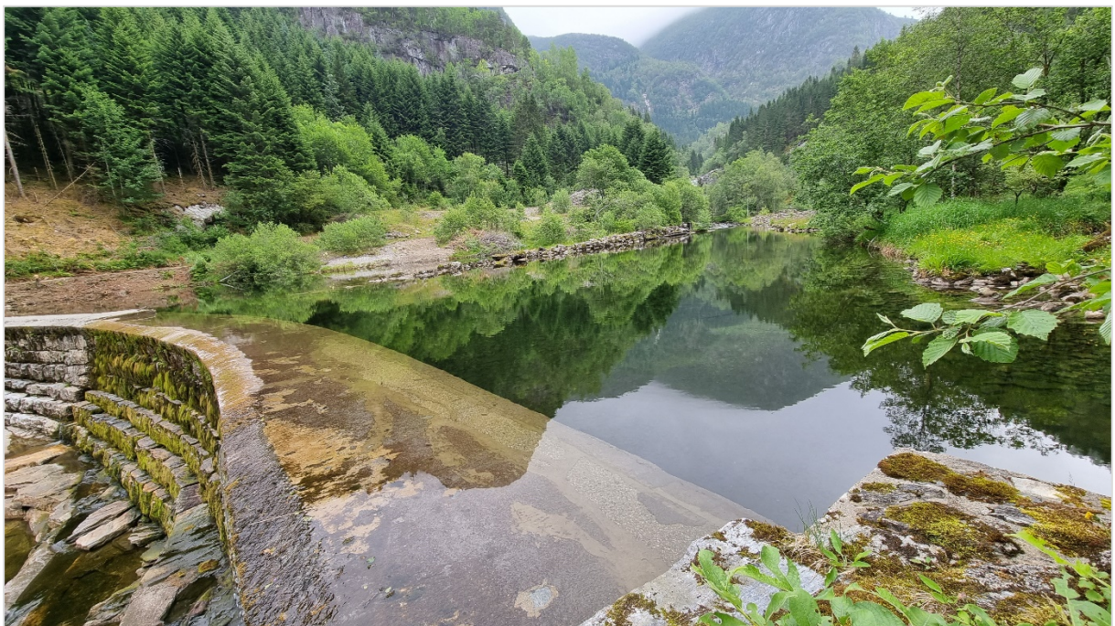
Figur 102 Inntaksdammen til Dale Fabrikker. Foto: 29.06.2021.
