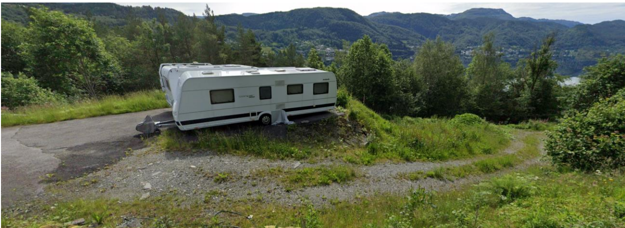
Figur 21: Bilde fra veien og ned mot Haukaneset. Området ved veien er planert ut med fyllmasser og asfaltert til en parkeringsplass. Foto: Google street veiw.
