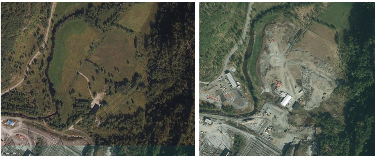
Figur 19: Ortofoto av Børdalen i 2020 og 2025. Det er tilført fyllmasser i området nord for trafostasjonen. Dette er innenfor tiltaksgrensen, se Figur 11. Foto: Norgebilder.no
