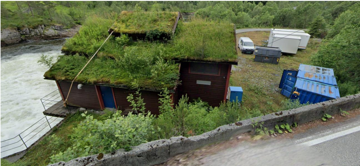
Figur 18: Foto av fyllmassene ved eksisterende Myra kraftverk, sett fra nord. Foto: Google street view.
