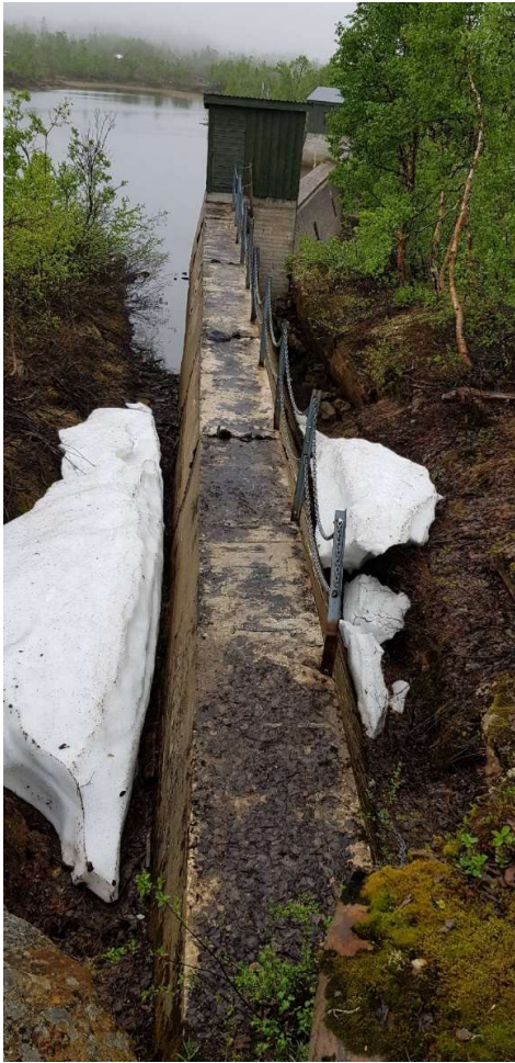
Østre landfeste, massivdam av betong
