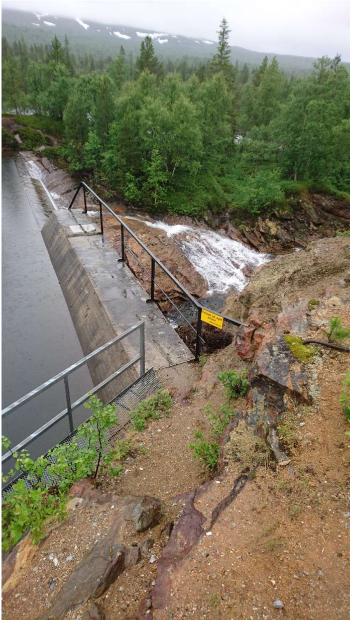
Inntaksdam Ildgrubfossen, hoveddammen (dam I/Inntak Ildgrubfossen)
