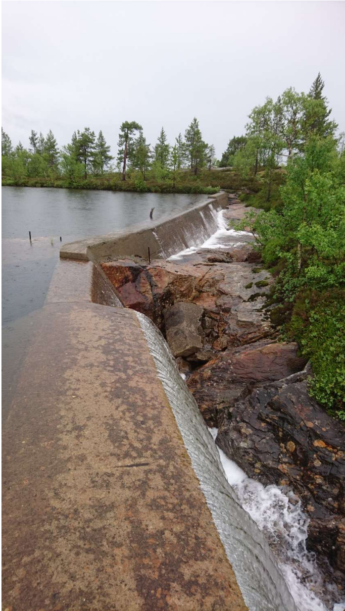
Inntaksdam Ildgrubfossen, dam III
