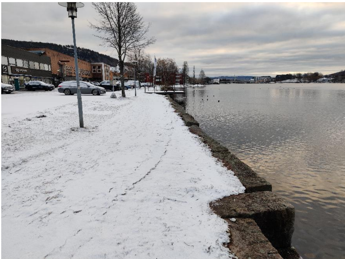
Bilde 2 Stablesteinmur langs elvekanten lengst vest på eiendommen.
