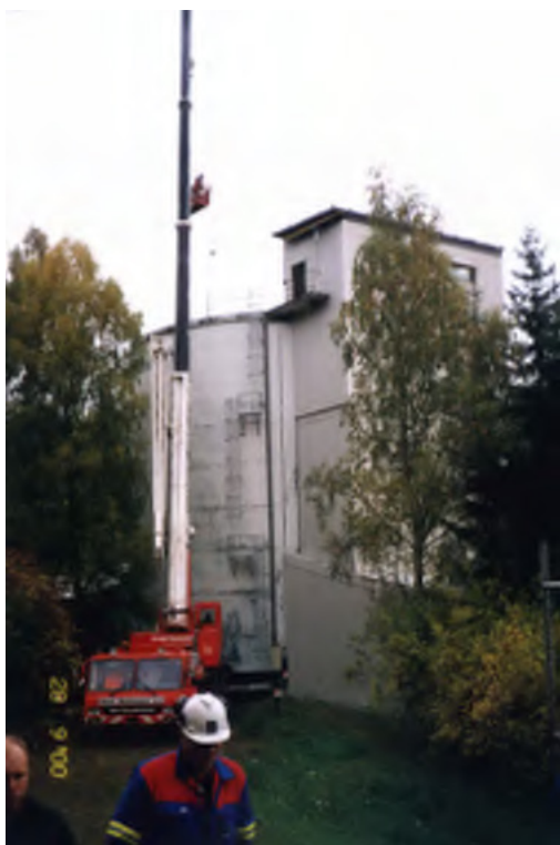
Inspeksjon av innvendig tårn fra mobilkrankurv
