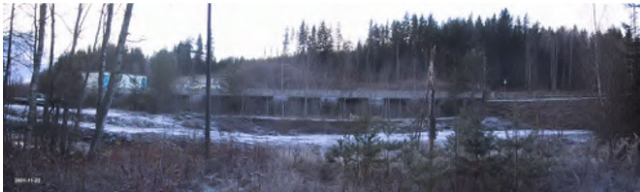
Oversikt over dammen sett fra nedstrøms side
