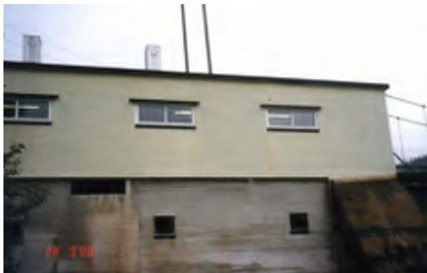
Inntaket sett fra nedstrøms side
