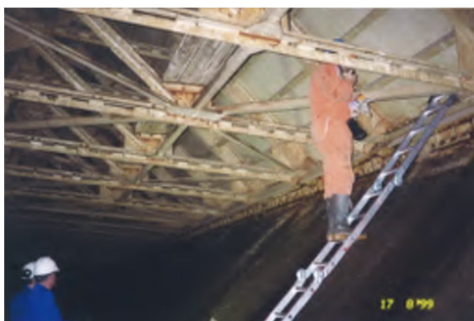
Undre fagverk sett mot lagre
