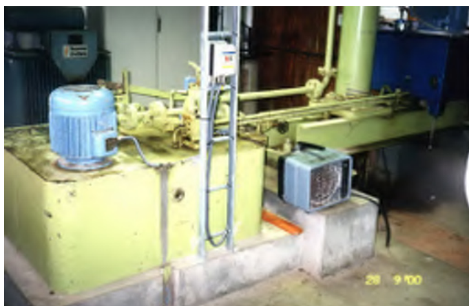
Hydraulisk aggregat og sylinder for høyre luke
