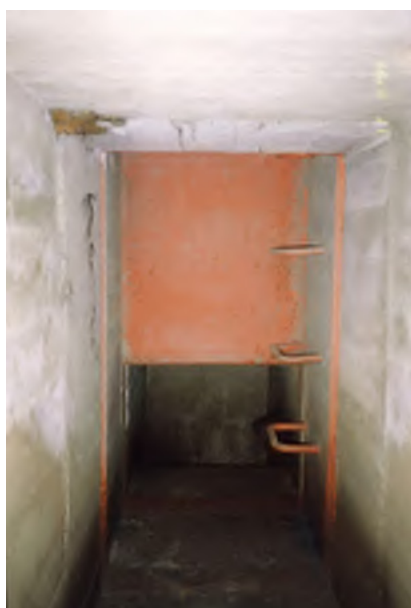
Luke i utløp fra rørlukekammer
