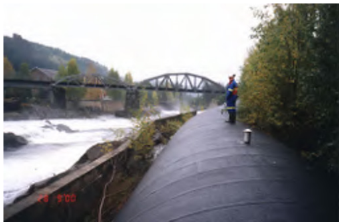
Isolert betongrør sett medstrøms
