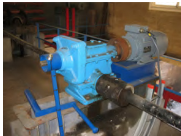
Bremsemotor og sveiv for nødbetjening 2005
