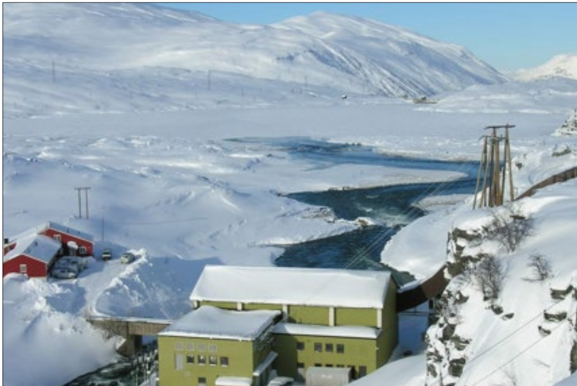
Figur 40. Åpent vann i utløpet fra Osbu kraftverk ved Holbuvatnet, som vil forsvinne når kraftverket nedlegges. Foto: Statkraft.
