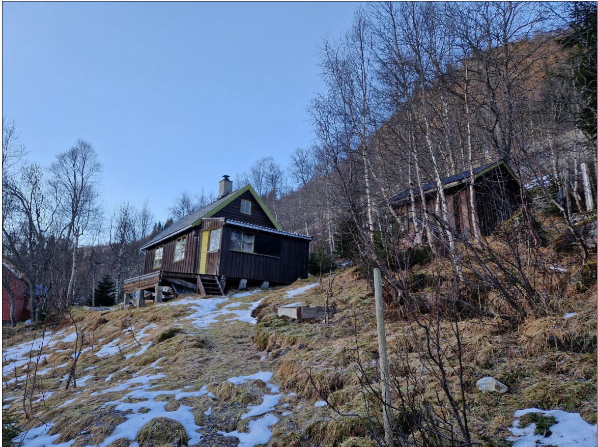
Figur 21: Kartlagt område ligger i jevnt hellende terreng og innenfor området er det en fritidsbolig og en mindre bod. Bilde tilsendt fra oppdragsgiver.
