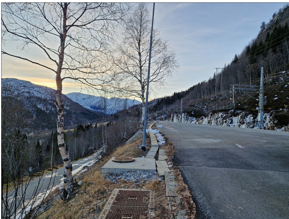
Figur 20: Bilde fra deler av flaten ved jernbanelinjen, i nedre deler av påvirkningsområdet. Bildet er tilsendt fra oppdragsgiver.
