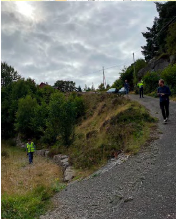
Figur 7. Støttemur ved Dalsvågen.
