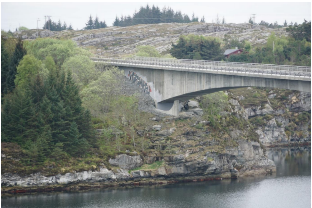
Figur 9. Kabelinnføring Svelgen bro.
