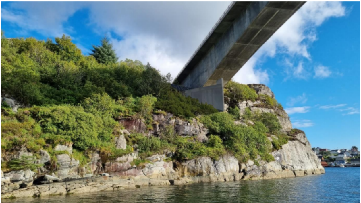
Figur 8. Kabelinnføring Solsviksundet bro.
