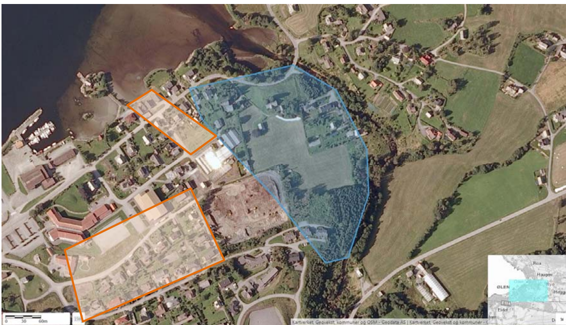
Figur 2-3: Flyfoto fra 2008 [7]. I område med blå skravur er det utført grunnundersøkelser i 2022 og område med oransje skravur i 2023.
