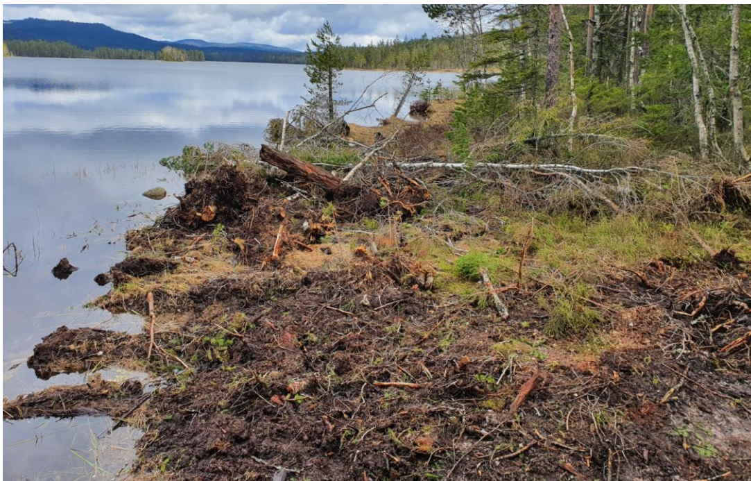
Figur 8: Noen mindre trær ligger igjen på bredden nord for dammen, disse skal bli fjernet i forbindelse med arbeidene.
