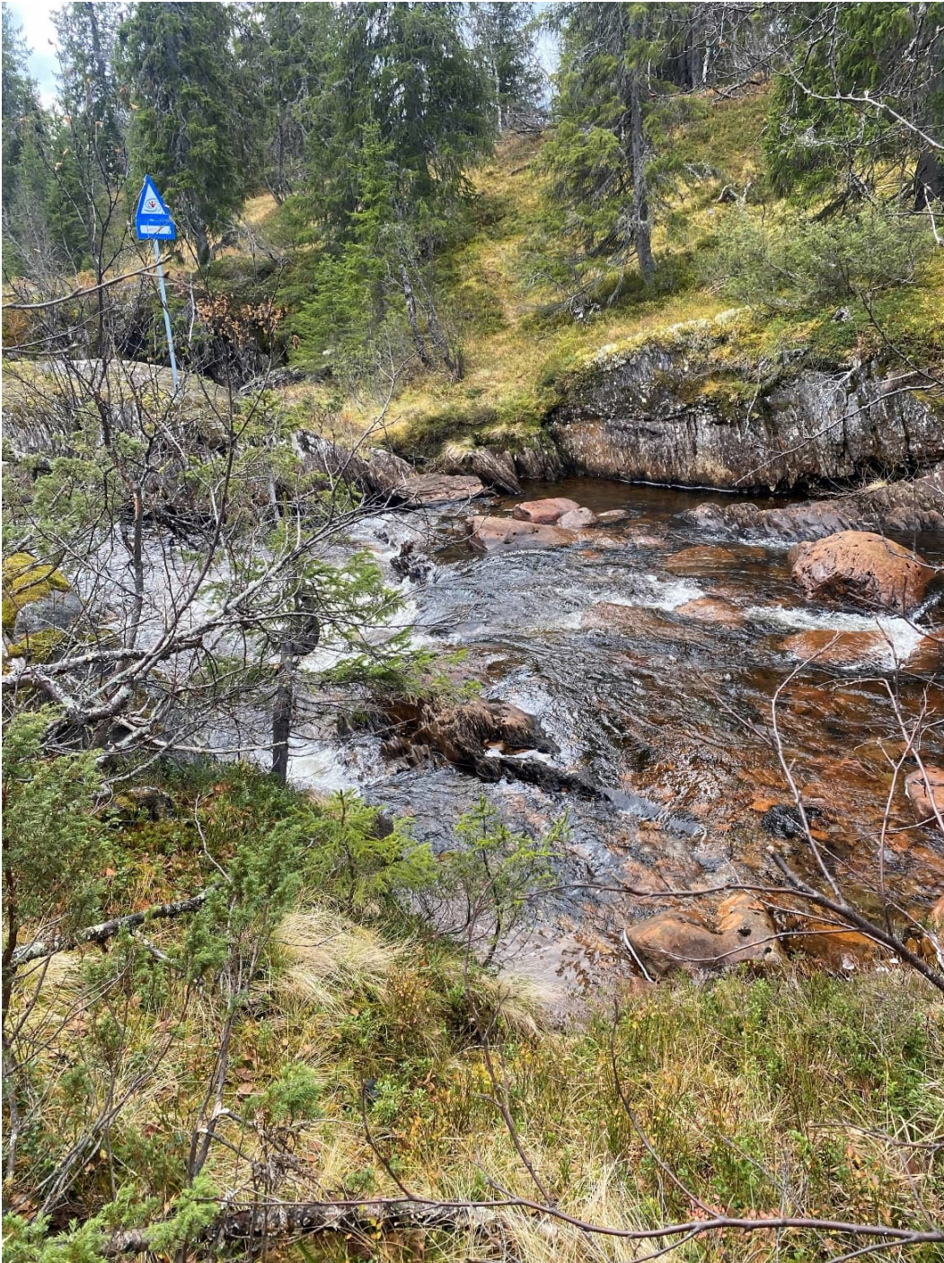
Figur 6-10. Område nord for dammen der terskel vil etableres. Kanal vi etableres i lite søkk til høyre for skilt i bakgrunnen. Bildet er tatt fra østsida av vassdraget mot vest. Foto: Sweco Norge.
