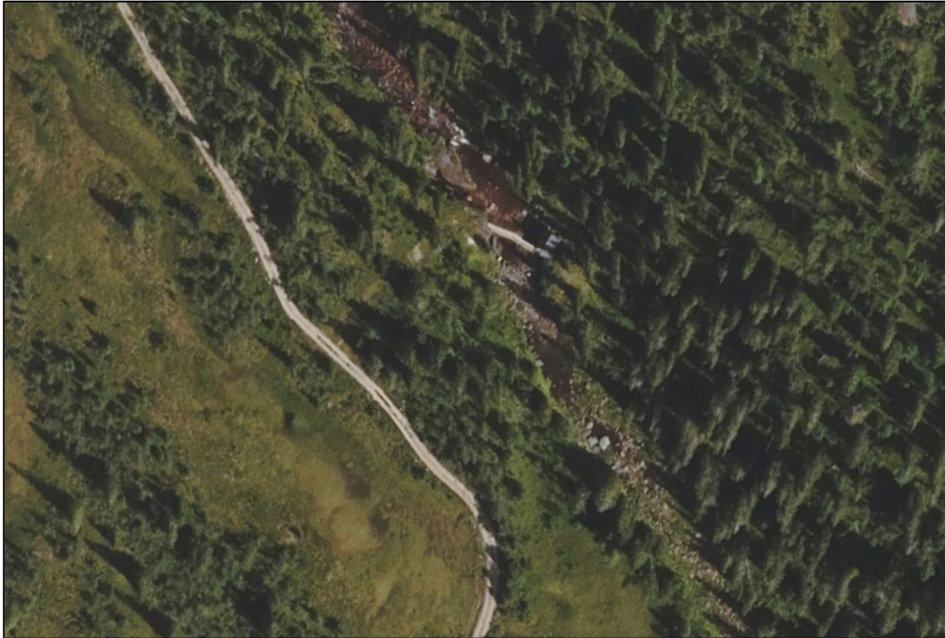
Figur 2-4. Ortofoto som viser dagens dam midt i bildet. Heiåveien til venstre i bildet. Elveleiet nedstrøms dammen er nesten tørt. Kilde: Norgeskart.
