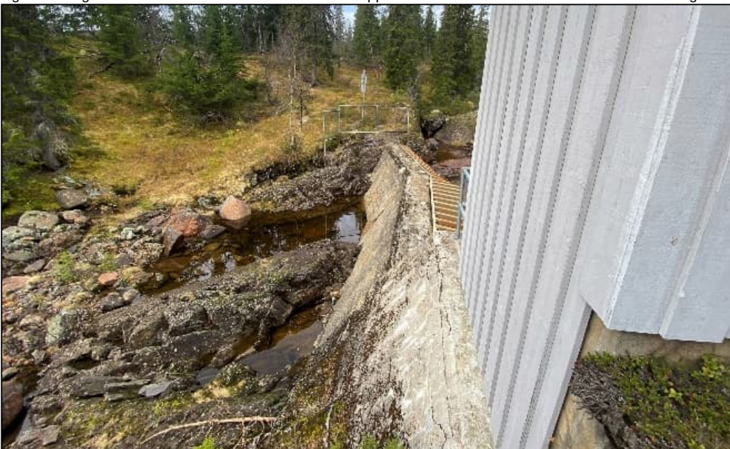
Figur 3-2: Dagens bekkeinntak i Heiåi. Bildet er tatt fra lukehuset og vestover. Foto: Sweco Norge.
