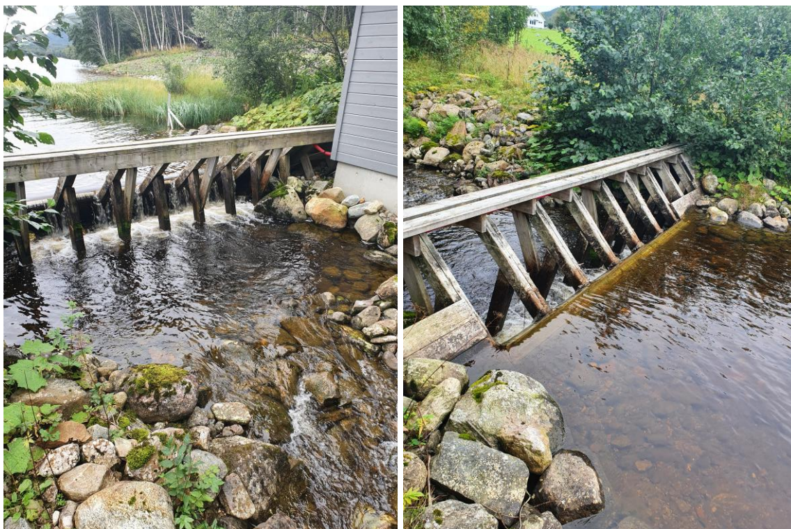
Figur 1 Damkonstruksjon i Belsvikbekken ved utløp av Heimsvatnet. Bredden på slissen i dammen justeres avhengig av vannføring.
