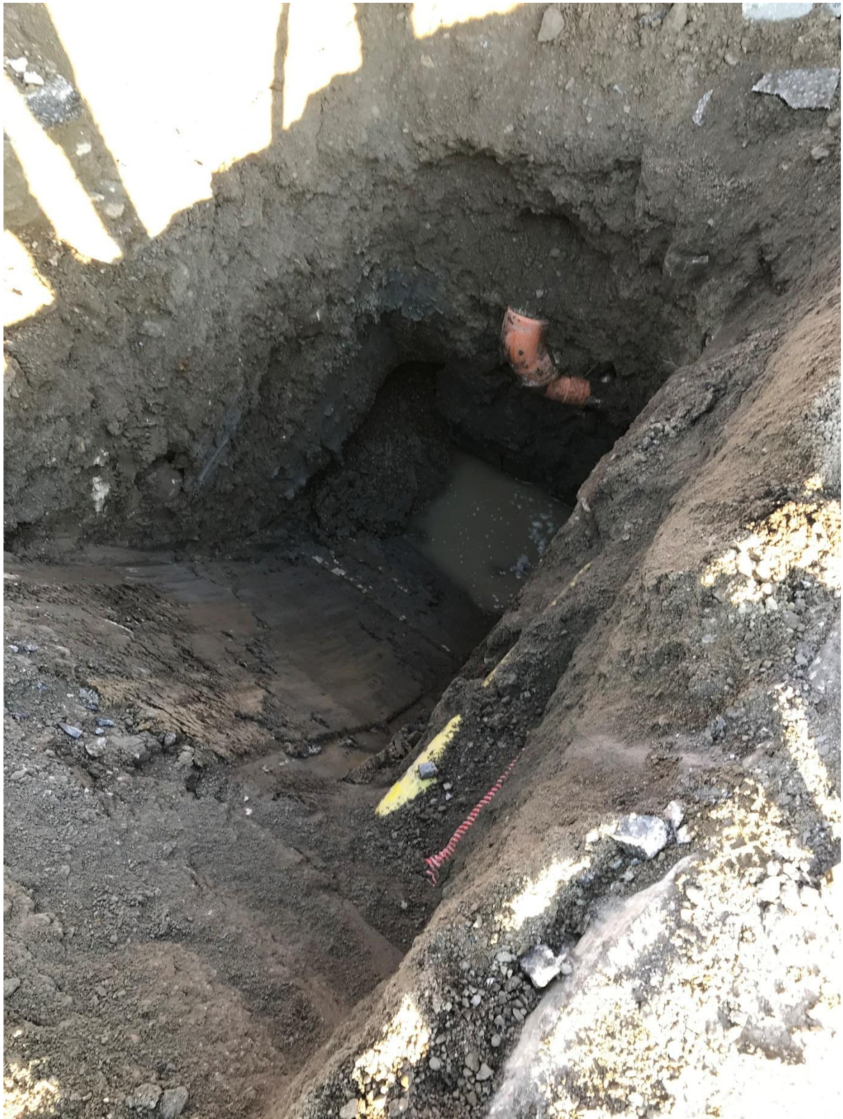
Prøvegraving punkt 5 Bilde 1
