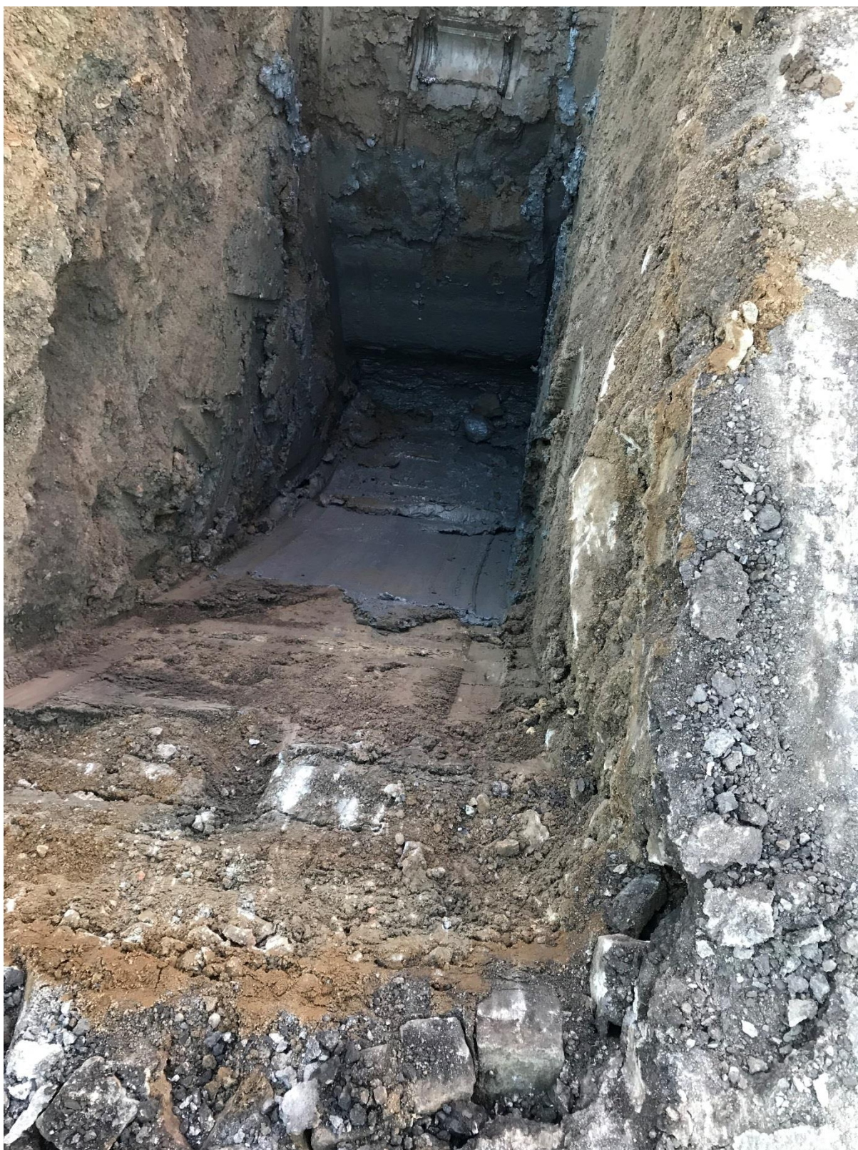
Prøvegraving punkt 6 Bilde 1
