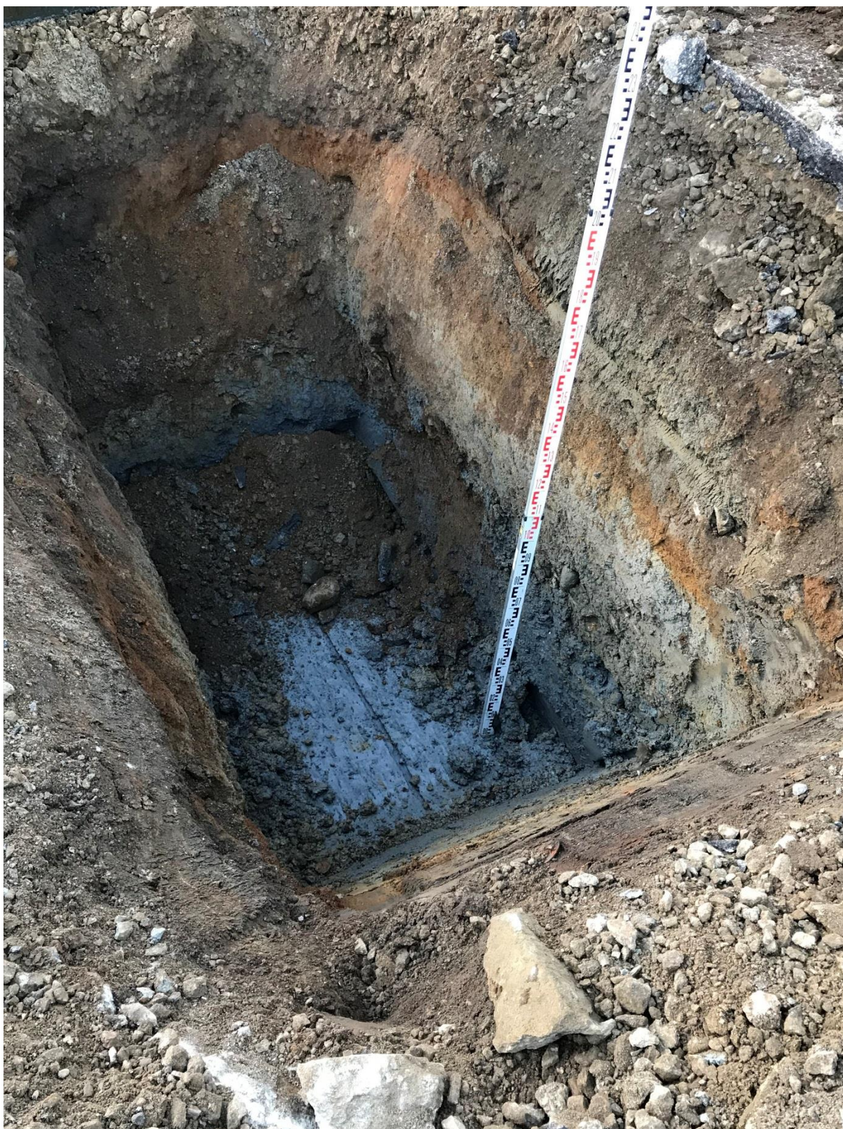
Prøvegraving punkt 1 Bilde 1
