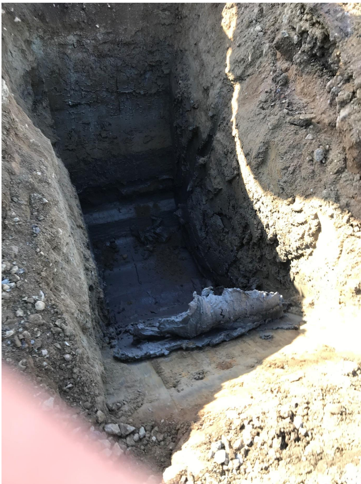
Prøvegraving punkt 2 Bilde 1
