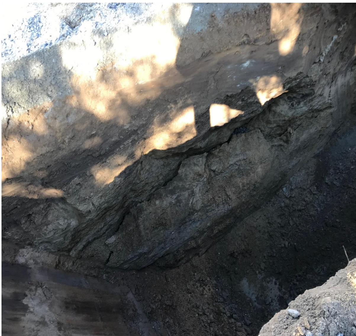
Prøvegraving punkt 7 Bilde 2
