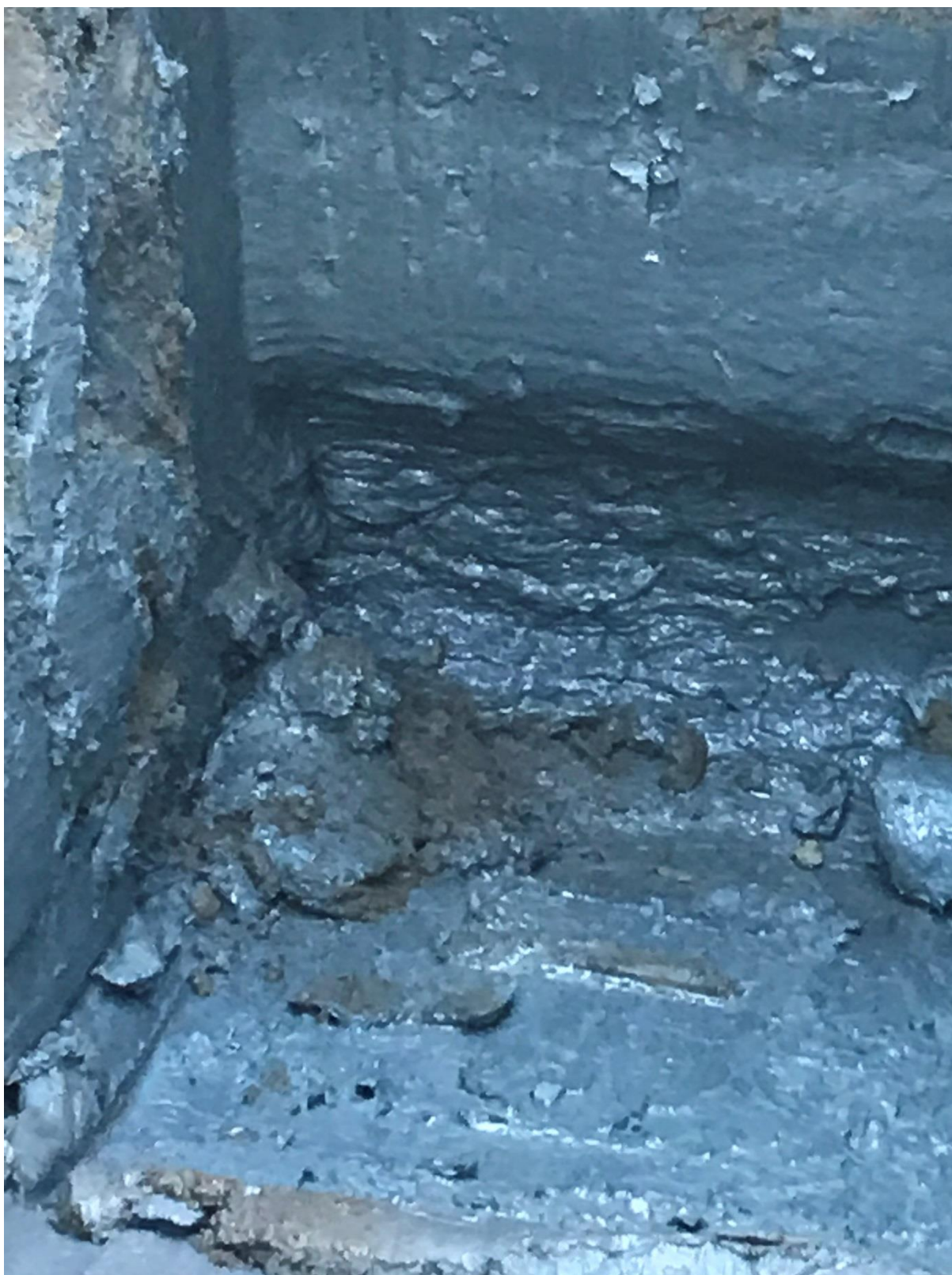
Prøvegraving punkt 6 Bilde 2
