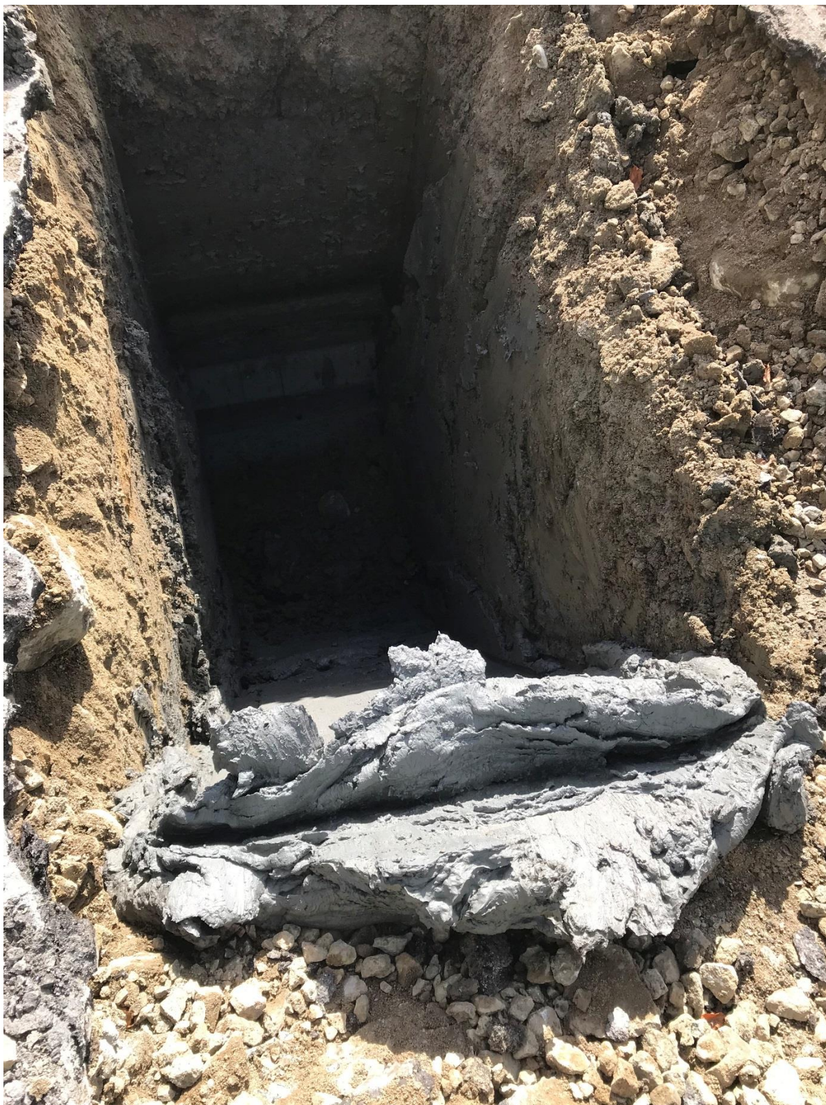
Prøvegraving punkt 4 Bilde 1
