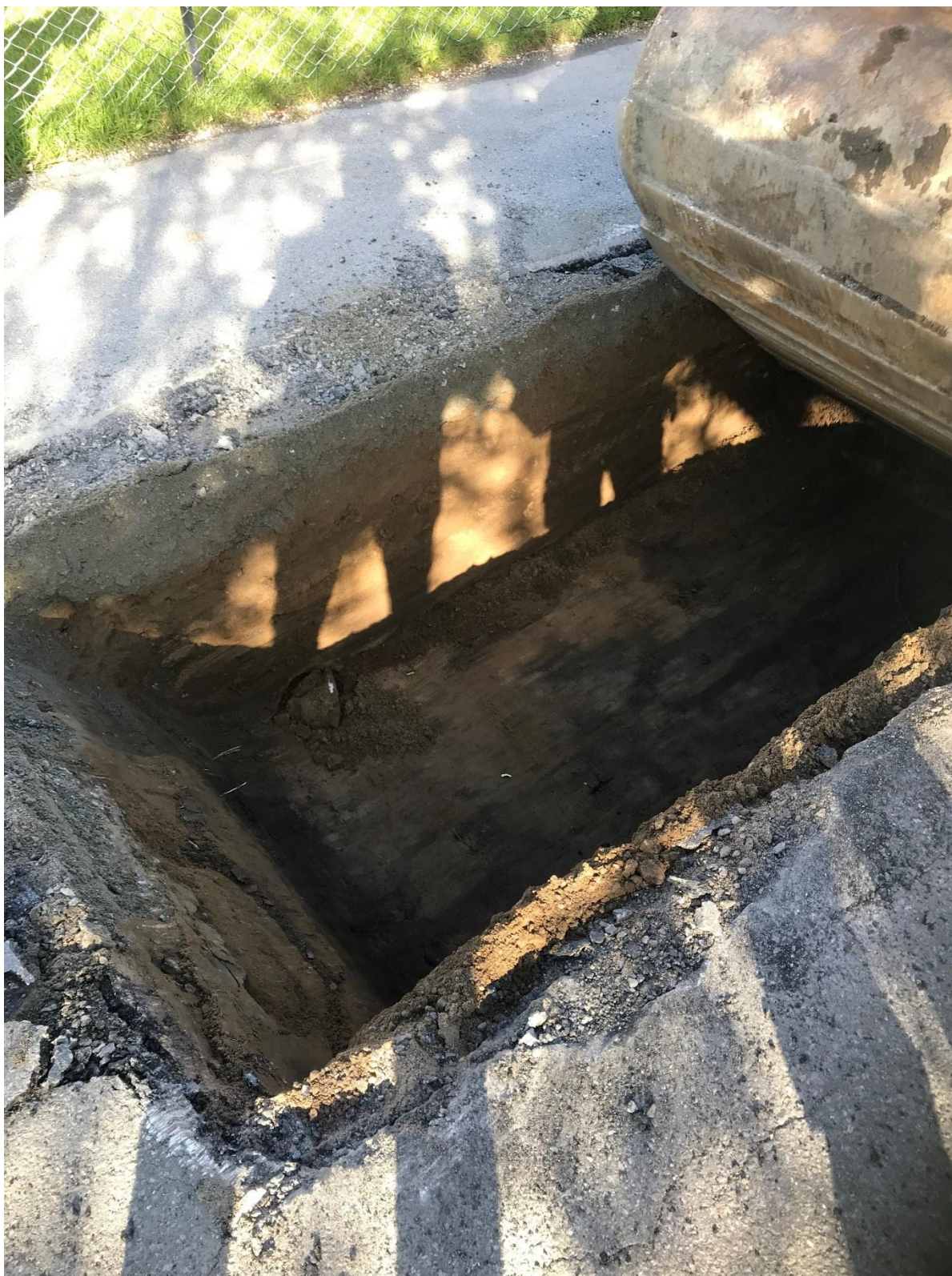
Prøvegraving punkt 7 Bilde 1
