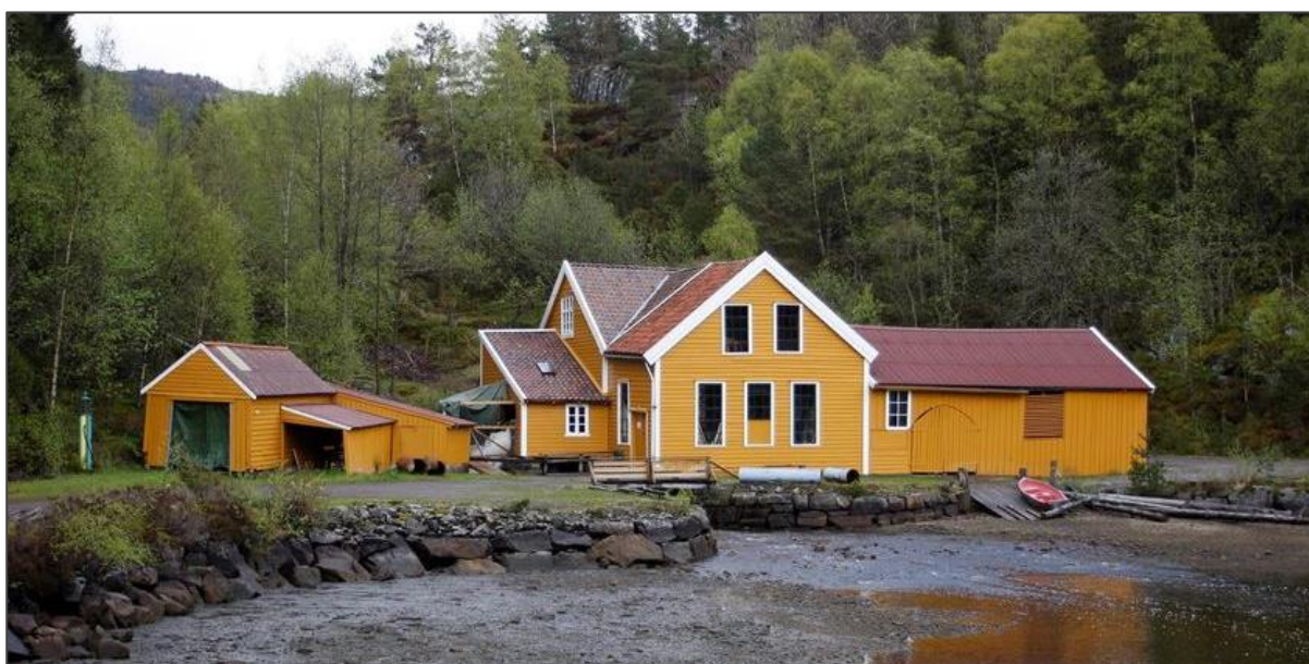
Figur 5-5. Sellevåg treskofabrikk. Sellevåg treskofabrikk. Foto: Ulf Ingmar Gustafsson. Fra Riksantikvarens Kulturminnesøk. CC BY-SA 4.0
