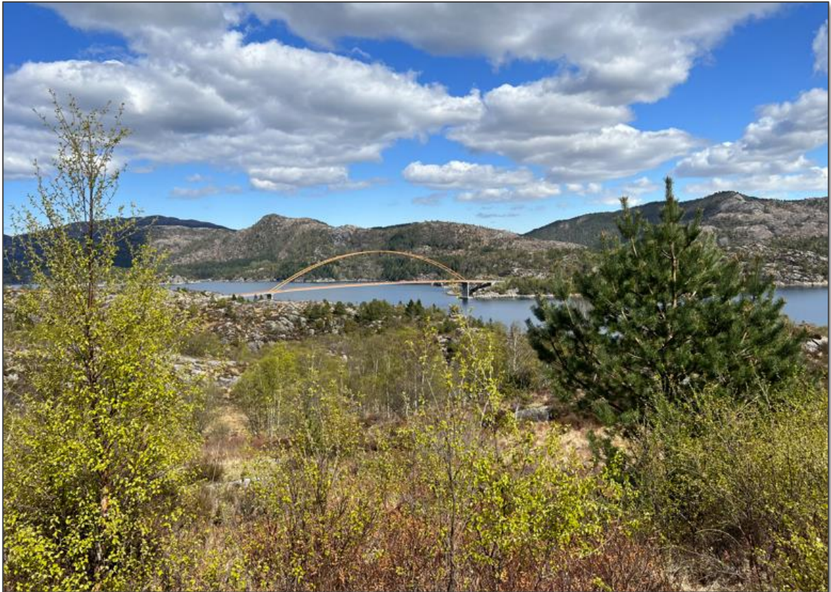
Figur 3-8. Brandangersundbrua med oransje bue og rekkverk. Foto: Åsta Midtbø, Multiconsult.
