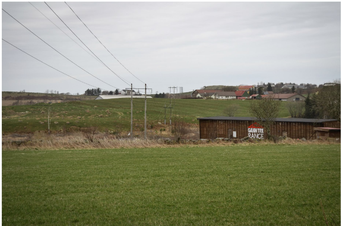
1. Dagens forhold med eksisterende 50 kV linje over golfbanen på Grødem sett mot nord. Håelva midt i bildet.
