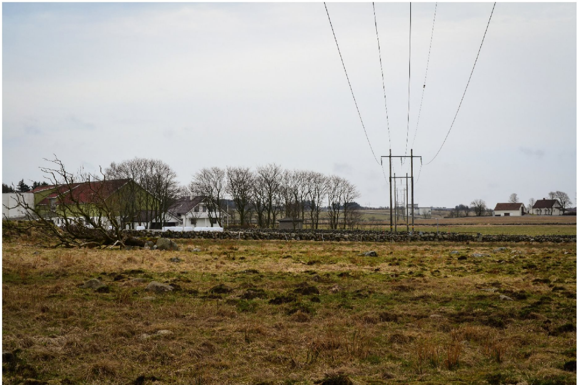
14. Dagens forhold med eksisterende 50 kV linje over Hagen/Håland sett sørover.
