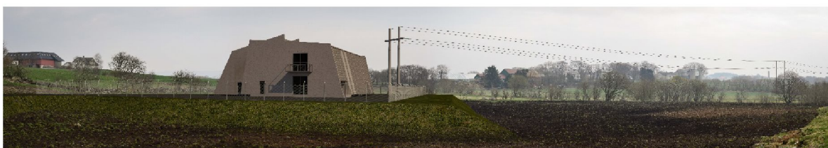
Vis.16. Alt. kombinasjon dobbelt-/enkeltkurs Opstad – Håland/Holen over Håland sett mot øst. Ny stasjon til venstre i bildet.
