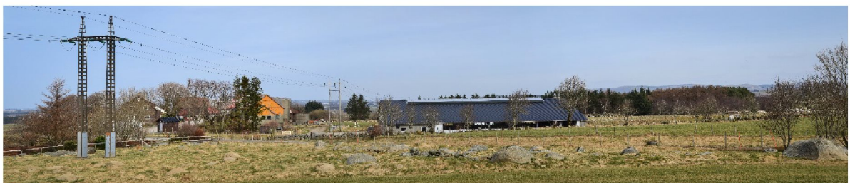
13. Dagens forhold med eksisterende 50 kV linje over Grødheim sett nordover.
