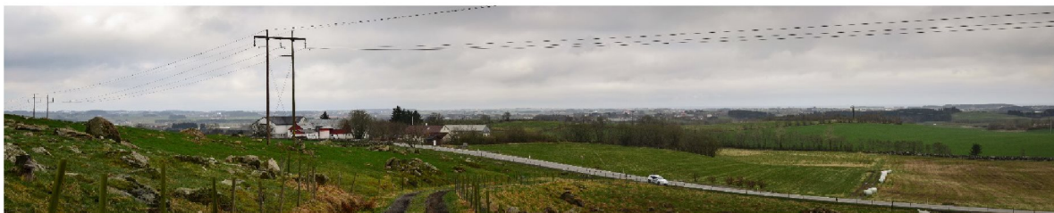
15. Dagens forhold med eksisterende 50 kV linje over Oma sett mot sørvest.
