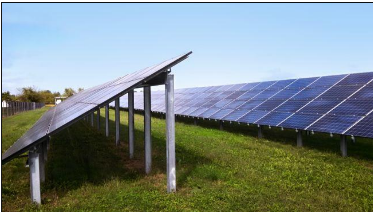
Figur 3-1: Fast-vinkel installasjonsløsning (foto: Willowbrook Solar).
