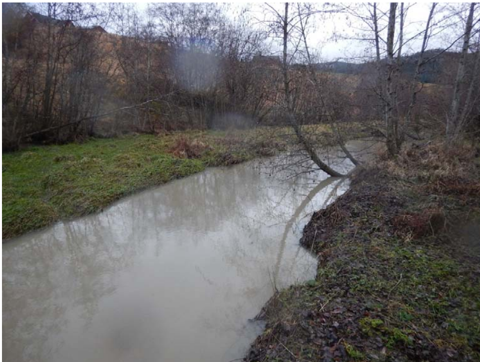
Figur 4: Ca. P900. Nesten ikke fall og stilleflytende. Ingen spor etter erosjon. Kompensasjonsgraving og erosjonssikring på strekningen P850-P960
