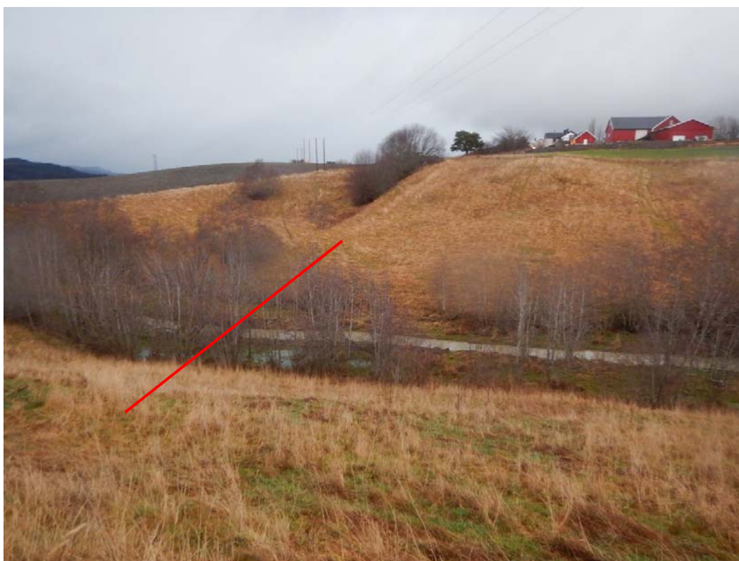
Figur 2: Rød strek ca. profil P800. Sikring i hele profilet avtrappes fra P750 ned til P850
