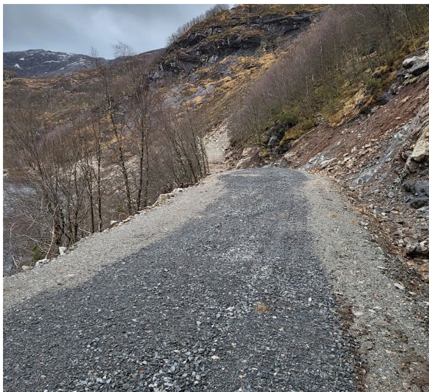
Figur 7 del av vegen som er heilt ferdig
