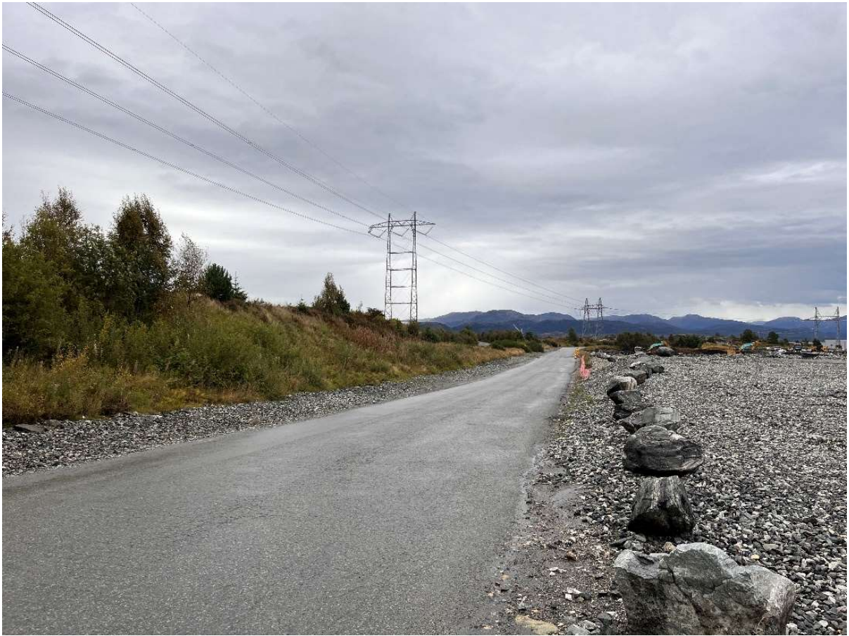
Figur 33: Bildet viser eksisterende kraftledninger som strekker seg fra Lindås transformatorstasjon og frem til Fensfjorden.
