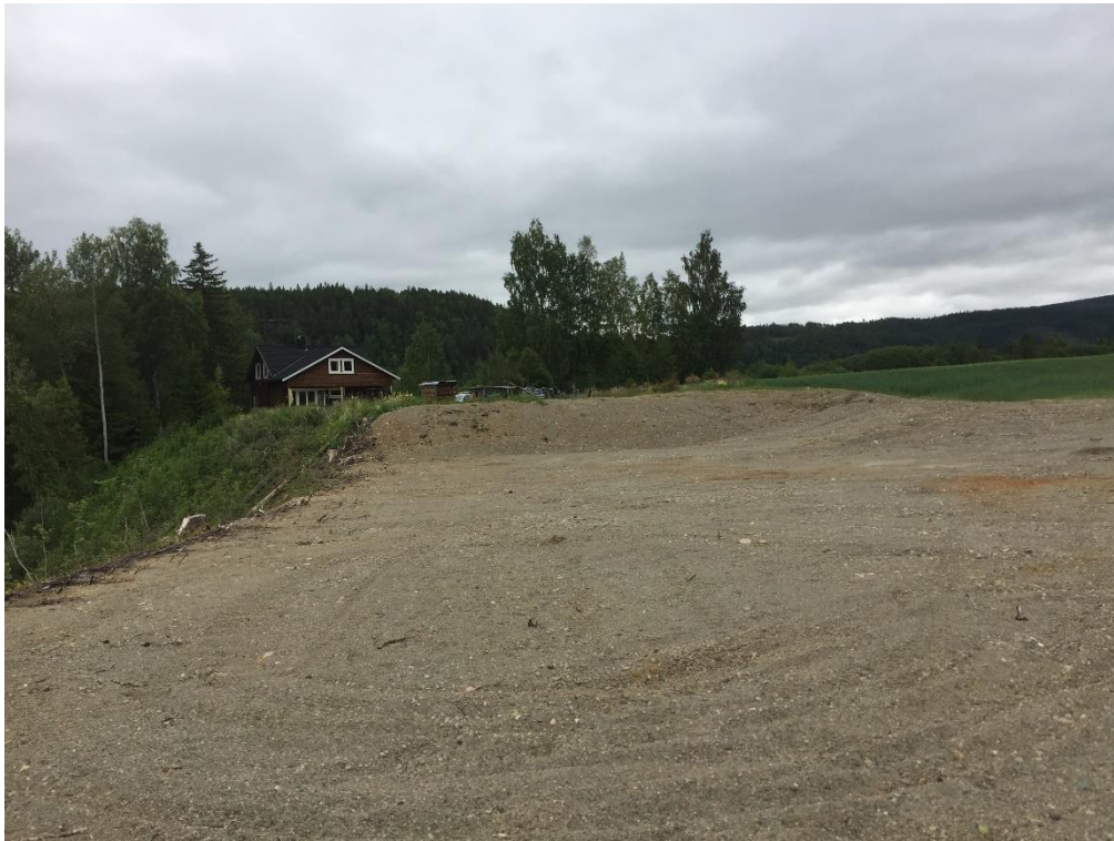
Figur 12: Ferdig avlasting – øvre platå. 04.07.2018.
