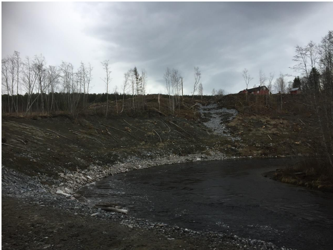
Figur 9: Ferdig lagt støttefylling og erosjonssikring av ravine, 23.04.2018.
