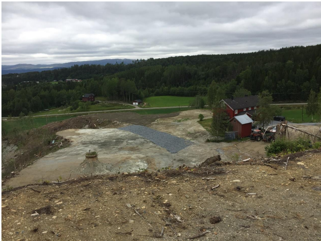
Figur 14: Ferdig avlasting, nedre platå. Bildet er tatt fra øvre avlastingsområde, 04.07.2018.
