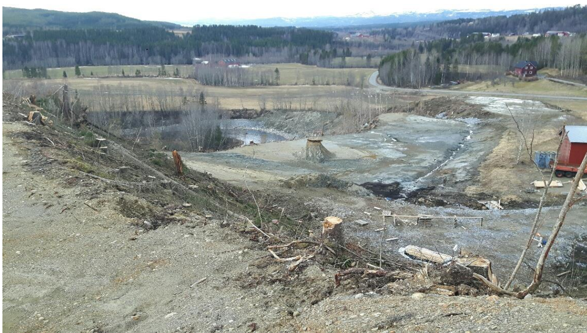
Figur 15: Nesten ferdig med avlasting og erosjonssikring, 23.04.2018.
