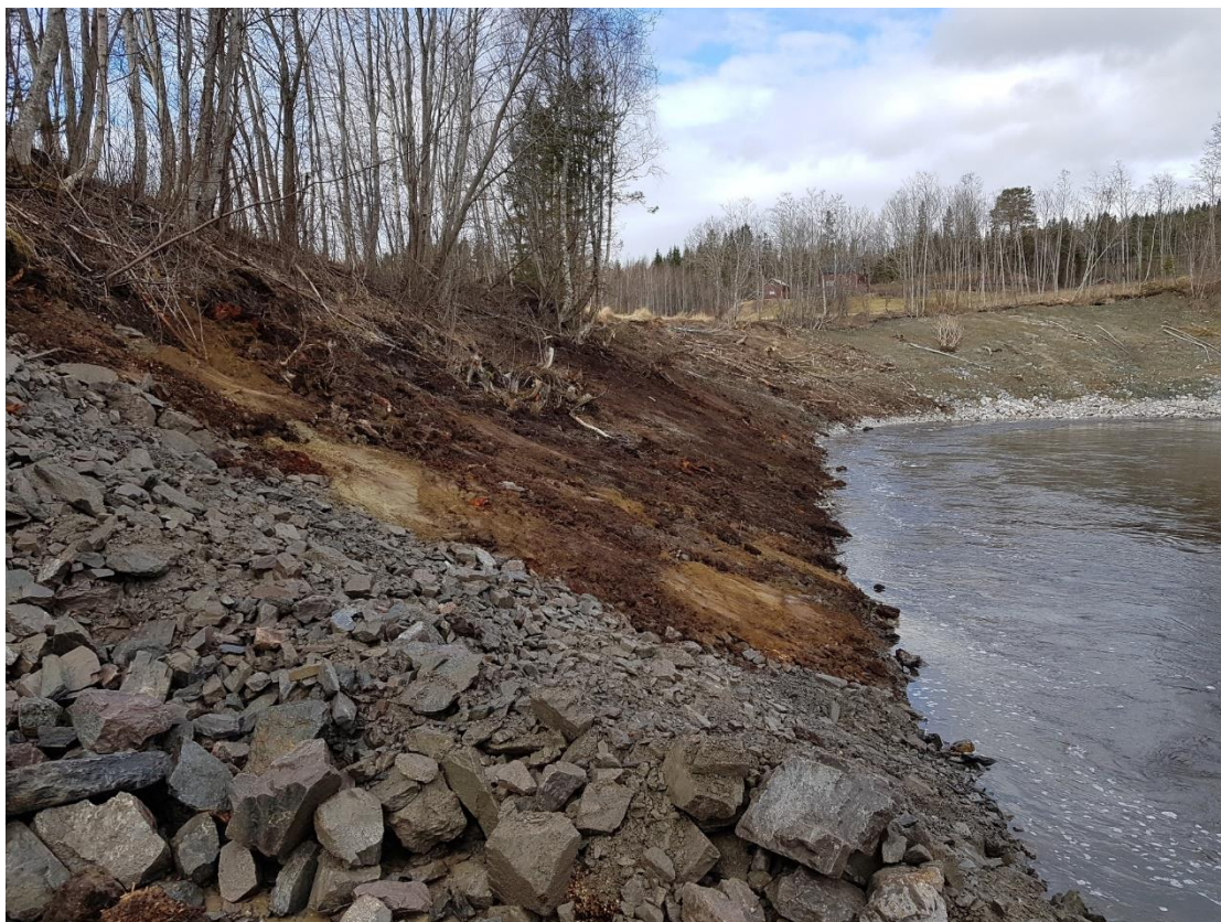
Figur 5: Slutførelse av erosjonssikring langs Jørstadelva 26.04.2018 (Foto Per Fagerstrand)
