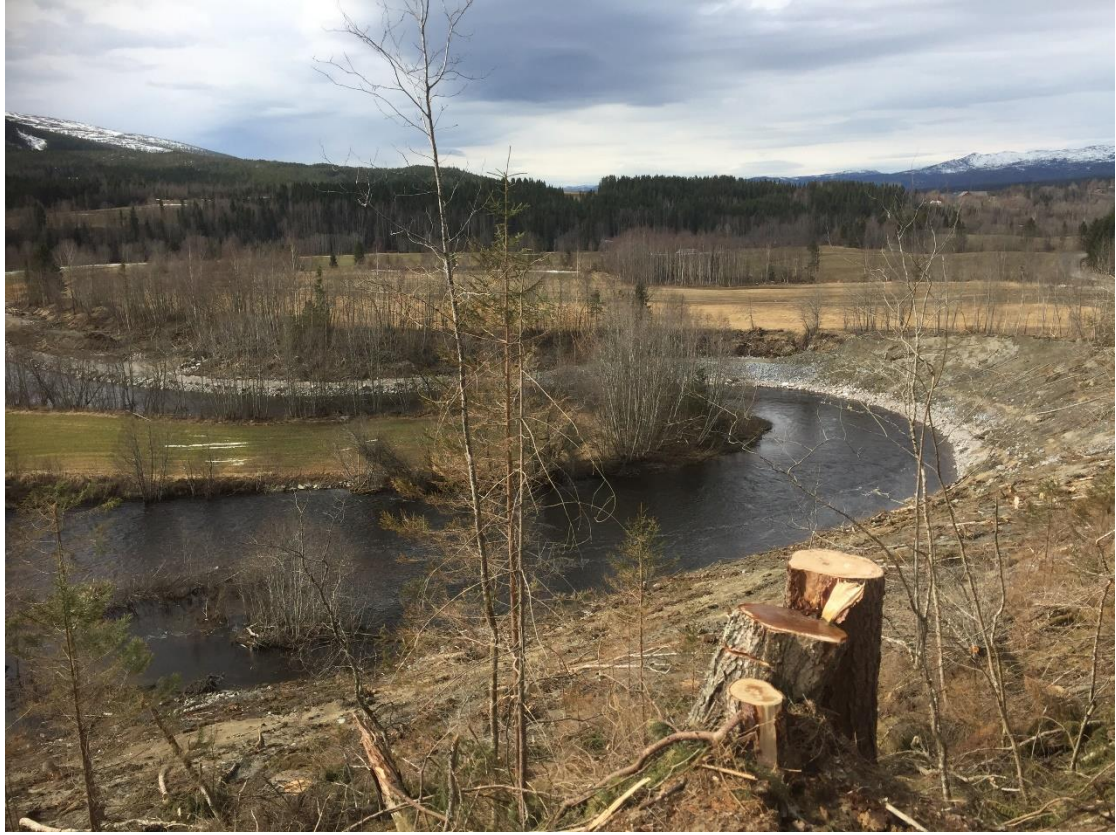
Figur 11: Ferdig støttefylling og nesten ferdig erosjonssikring, 23.04.2018
