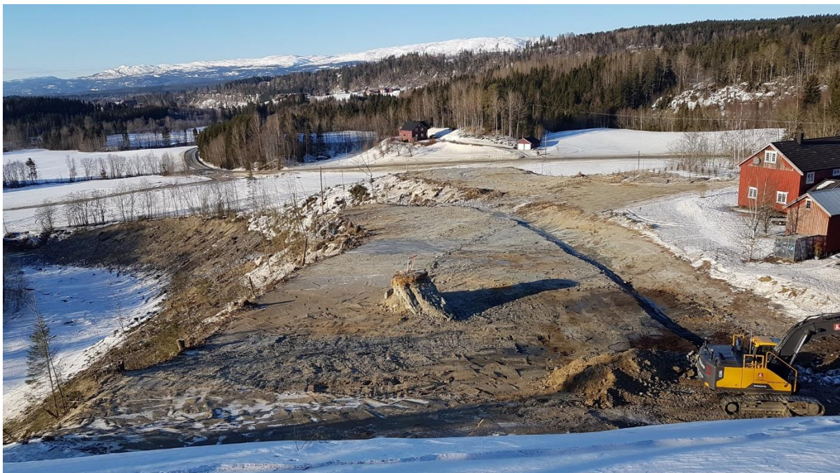
Figur 13: Nesten ferdig med avlasting av nedre platå, 13.02.2018.
