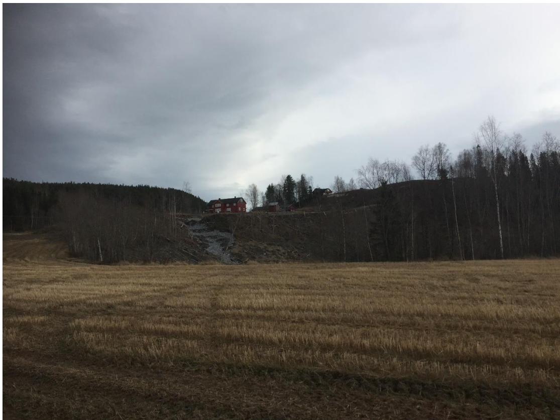
Figur 10: Ferdig støttefylling og erosjonssikring av ravine, 23.04.2018.
