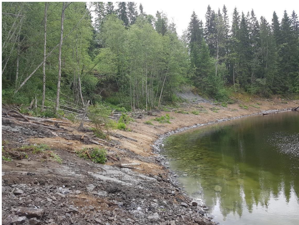
Figur 6: Ferdig lagt erosjonssikring langs Jørstadelva, 13.06.2018 (Foto: Per Fagerstrand).
