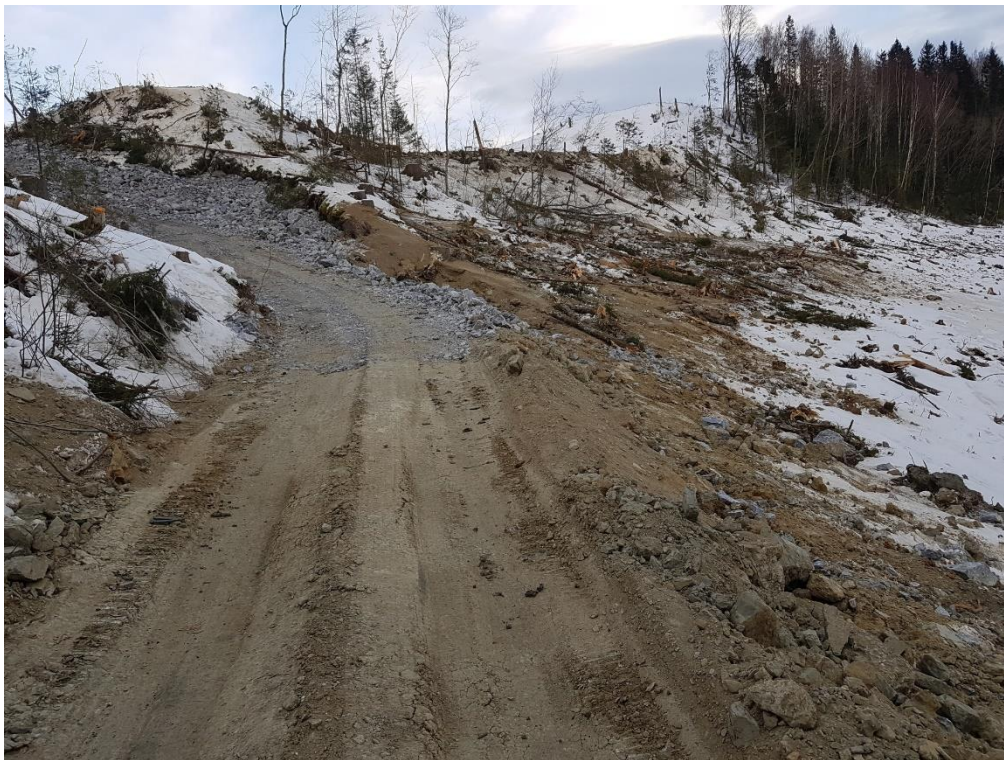
Figur 7: Legging av støttefylling og erosjonssikring av ravine (01.02.2018) (Foto: Per Fagerstrand).
