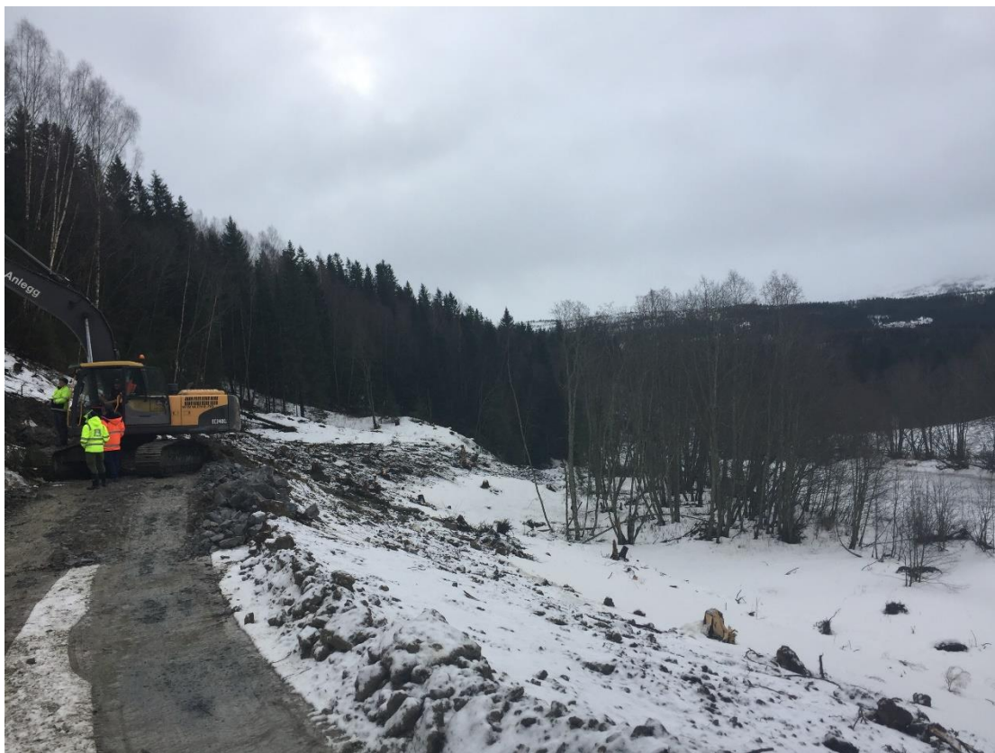
Figur 4: Utførelse av erosjonssikring langs Jørstadelva, 25.01.2018
