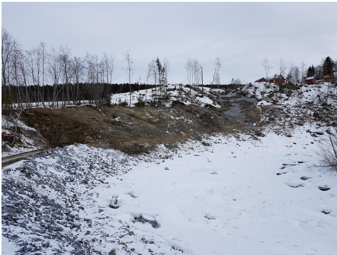
Figur 8: Legging av støttefylling. Ferdig erosjonssikring av ravine, 08.02.2018 (Foto: Per Fagerstrand).
