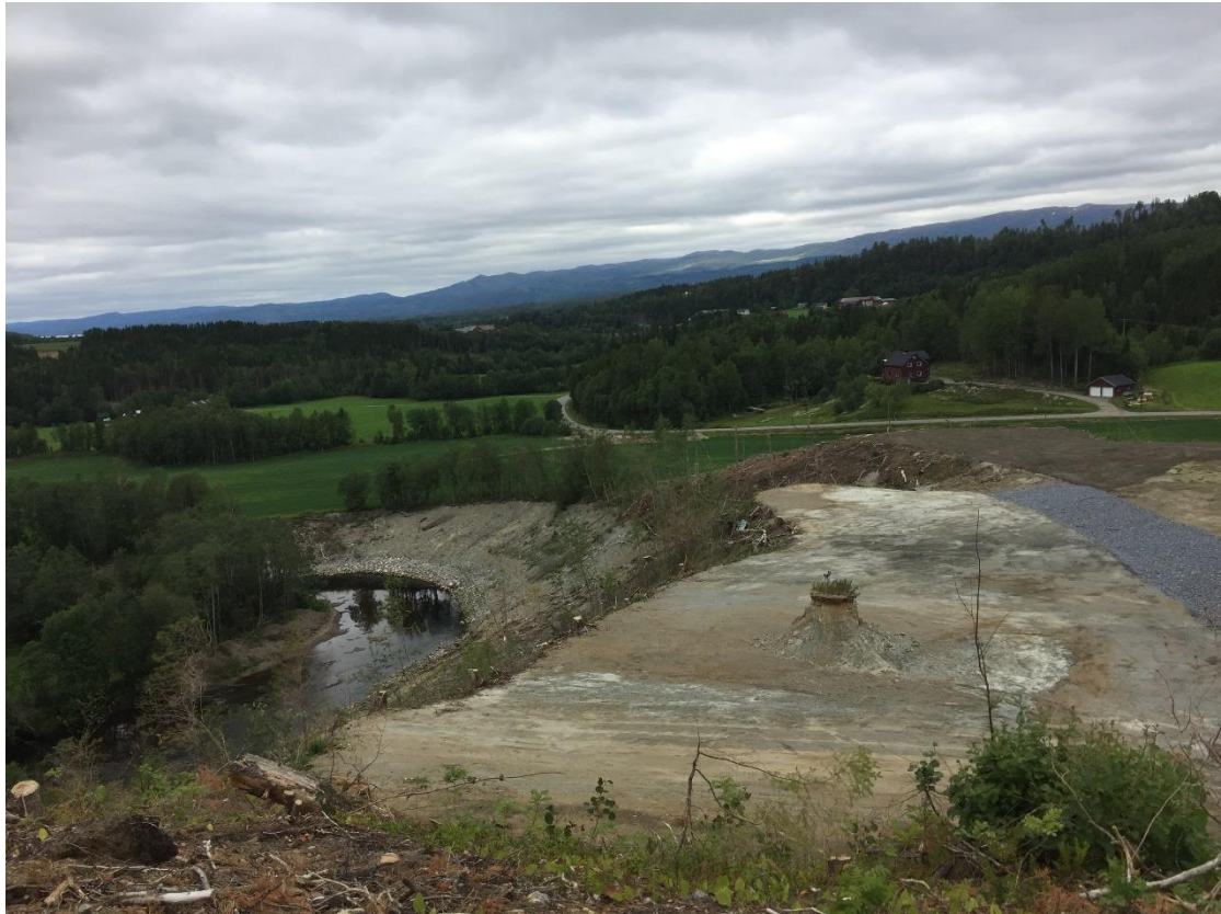
Figur 16: Ferdig avlasting, støttefylling og erosjonssikring, 04.07.2018. «Monolitten» som står igjen på avlastingsplatået var plasseringssted for piezometerne til Rambøll, brukt til å registrere og overvåke poretrykket under bygging av sikringstiltaket. Dette viser opprinnelig terrengnivå før avlasting.
