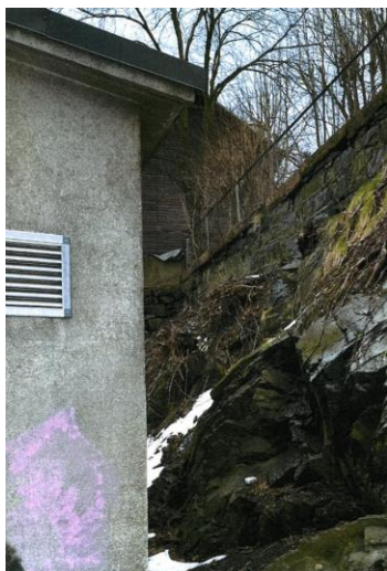
Figur 7-3: Eksisterende/ny likeretter står direkte på berg
