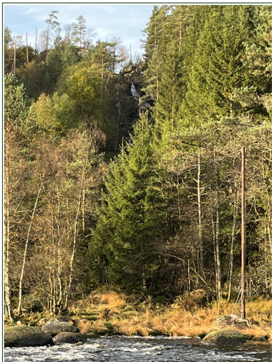
Figur 4 Foss med overløp og anlegget i drift. Tatt fra utsiktspunkt langs vei vest for Kvina. Foto: NVE
