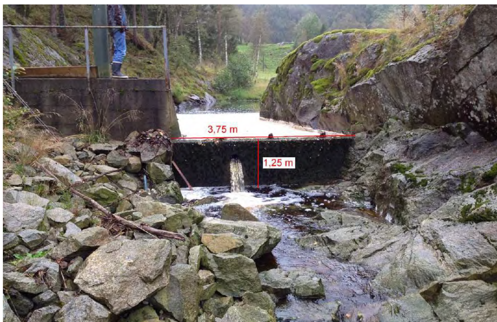
Figur 2: Eksisterende inntaksdam, som også skal benyttes videre. Kilde: fra søknad.
