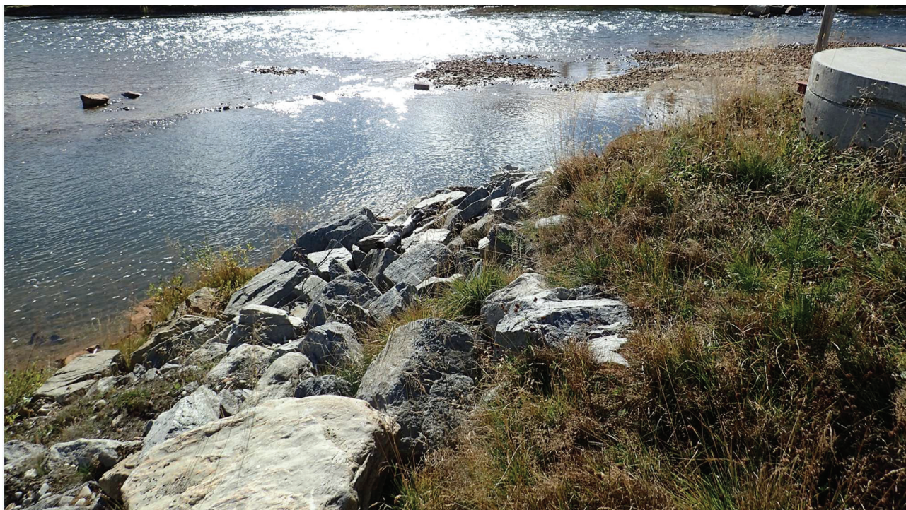
Figur 6-7 Sikring av kum ved utslippspunkt
