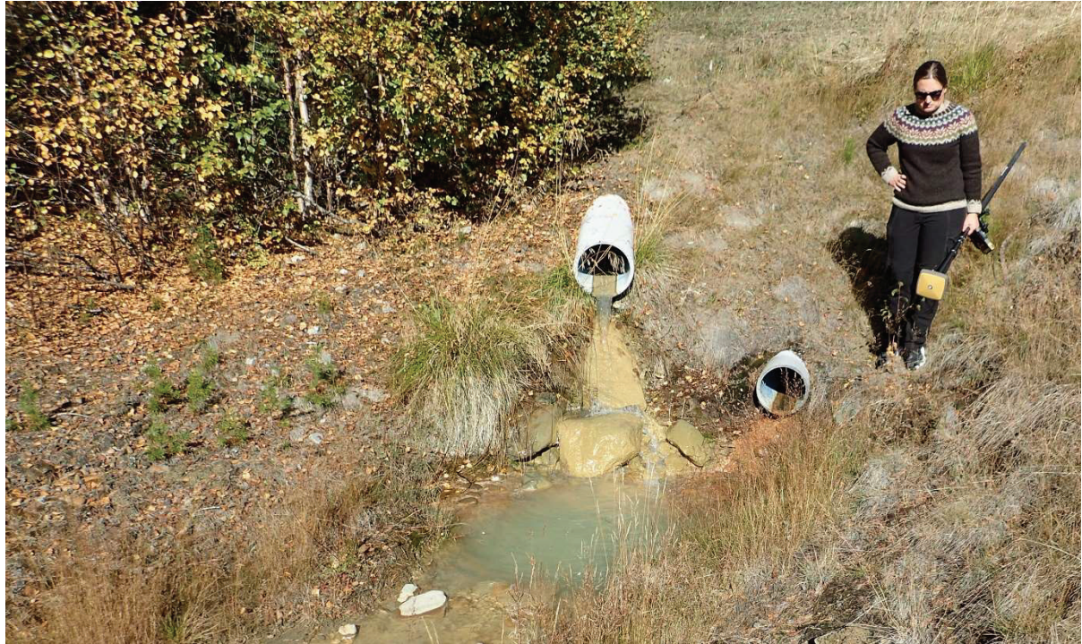
Figur 5-2 Gammelelva, utløp av stikkrenner under Folldalsvegen
