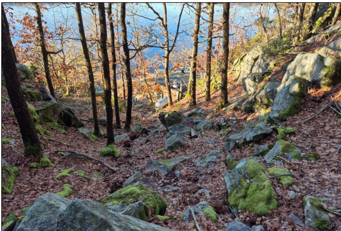
Figur 3: Steinsprangblokker med tynt humusdekke imellom, sett fra søkk ned mot vanntank og eksisterende hytte. Ingen spor etter ferske steinsprangblokker, maksimal registrert utløpslengde i overkant av vanntank.
