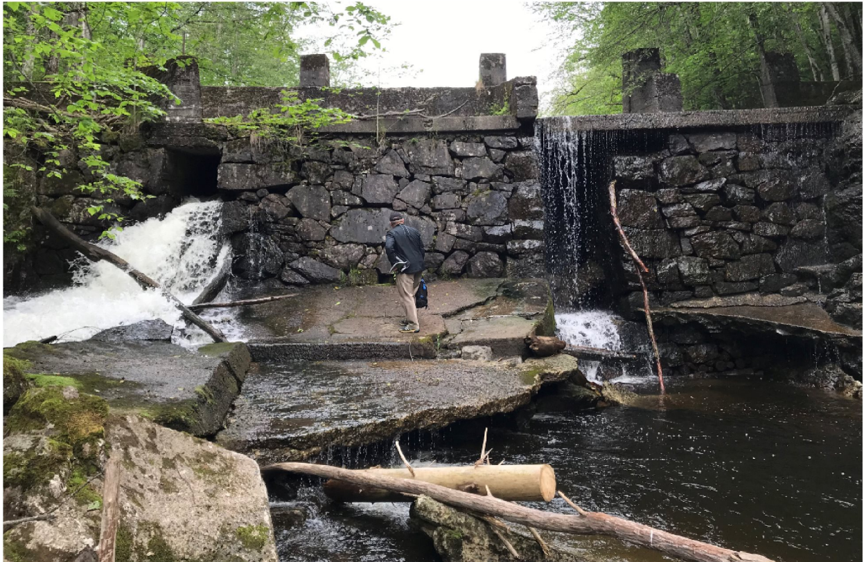
Figur 3: Bjørumdammen sett fra nedstrøms side.
