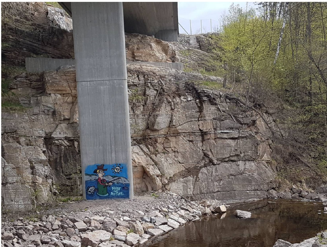
Figur 9: Øst for dammen er det mer skifrige/kalkholdige bergarter. Betongkonstruksjonen på bildet er en del av Bjørumsag bru.
