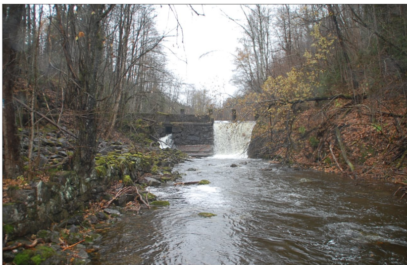
Figur 27: Dammen sett i retning nordvest.
