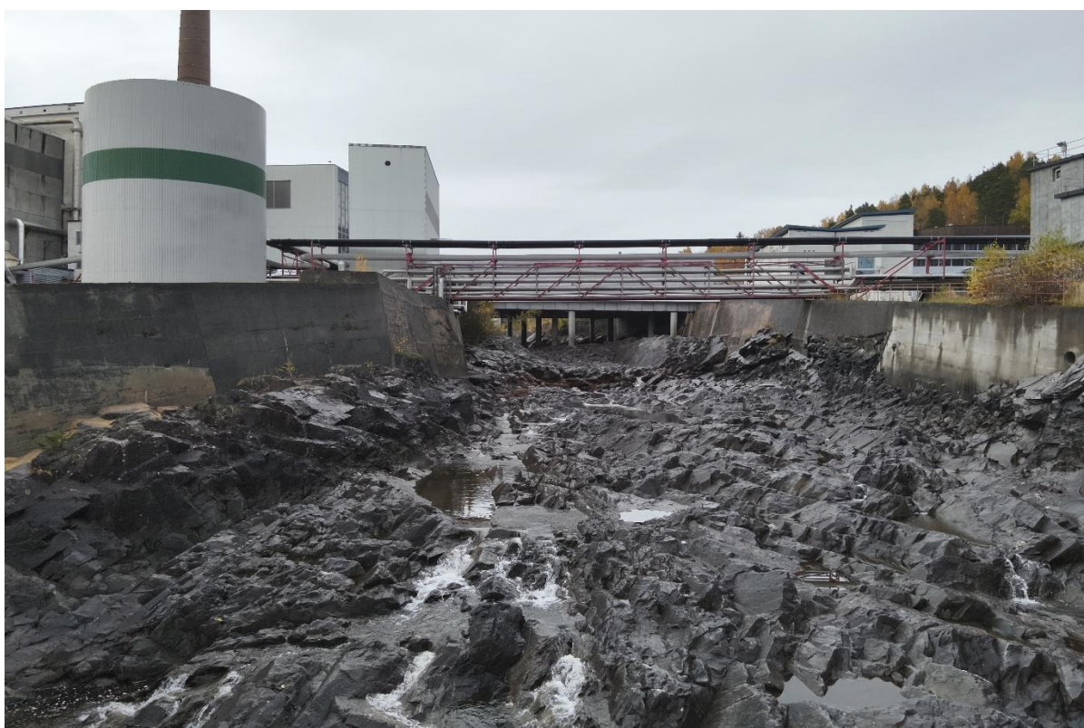
Øverst: Hofsfoss dam med flomluke. Nederst: Elveleiet på berørt elvestrekning gjennom industriparken.
