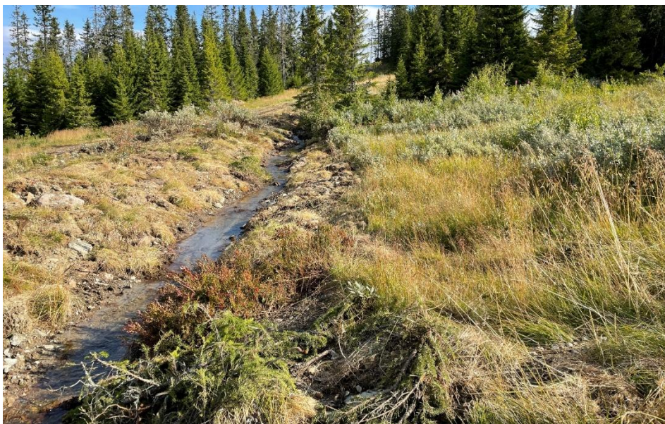
Figur 18: Eksempel på nyetablert bekkeløp på Hafjell fra 2022 hvor prinsippet over er lagt til grunn og vegetasjonsflak er lagt tilbake oppå erosjonssikringen. Foto: Skred AS
