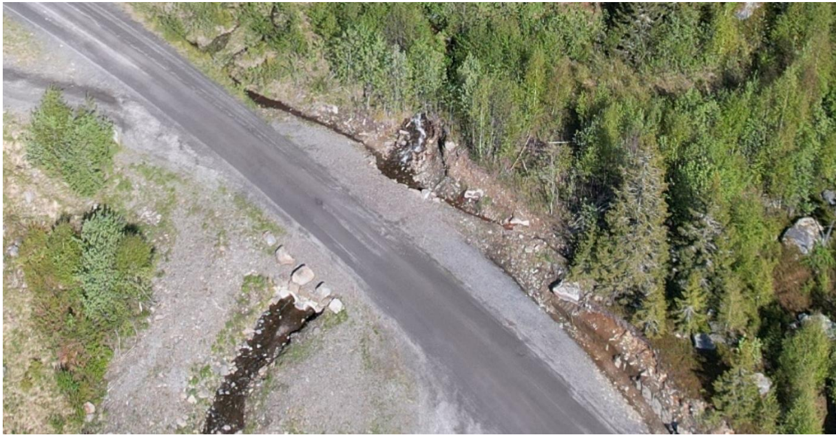
Figur 3: Dronebilde av der Stubberudbekken krysser Storsteinvegen.
