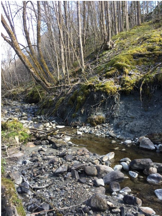
Bilde 221: Erosjon i skråningen på venstre side.
