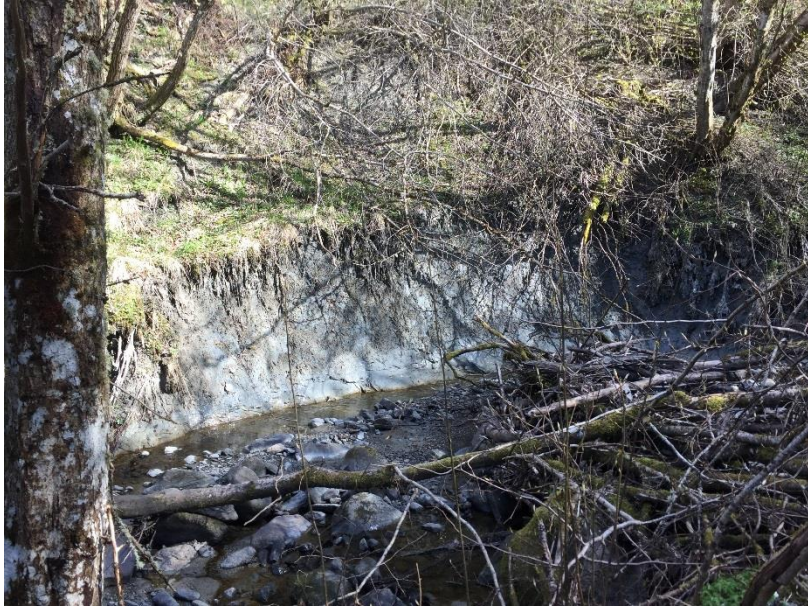
Bilde 198. Erosjon med blottlagt leire
