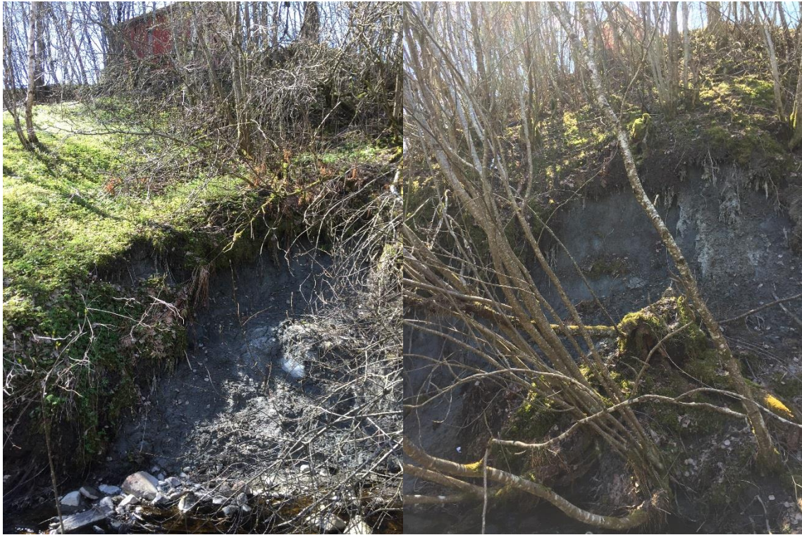
Bilde 319 og 322. Erosjon mot Knut Aalbergs eiendom
