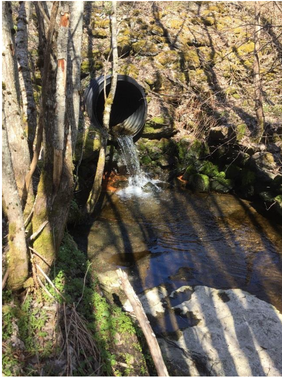
Bilde 303 og 304: Hhv utløp og innløp av rør. Legg merke til berg i bekkebunn ved utløpet. Partiet oppstrøms innløpet er noe roligere, og få tegn til erosjon.
