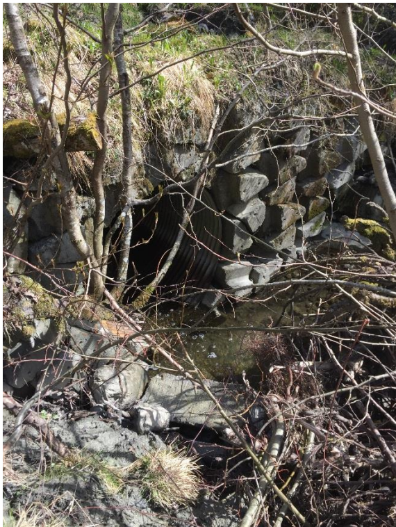
Bilde 254 og 260: Hhv utløp og innløp av rør. Innløpet er nærmest gjentettet av kvist og skrot og danner en terskel, med roligere strømningsforhold oppstrøms.
