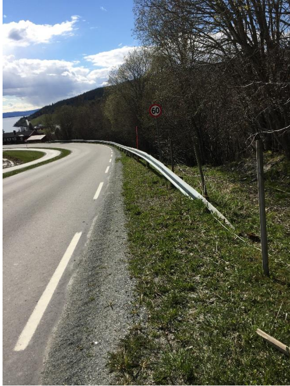
Bilde 252. Erosjon og utglidning like ved fylkesveien. Bilde 327: Autovernet ved fylkesveien står noe skrått..
