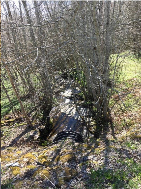
Bilde 303 og 304: Hhv utløp og innløp av rør. Legg merke til berg i bekkebunn ved utløpet. Partiet oppstrøms innløpet er noe roligere, og få tegn til erosjon.
