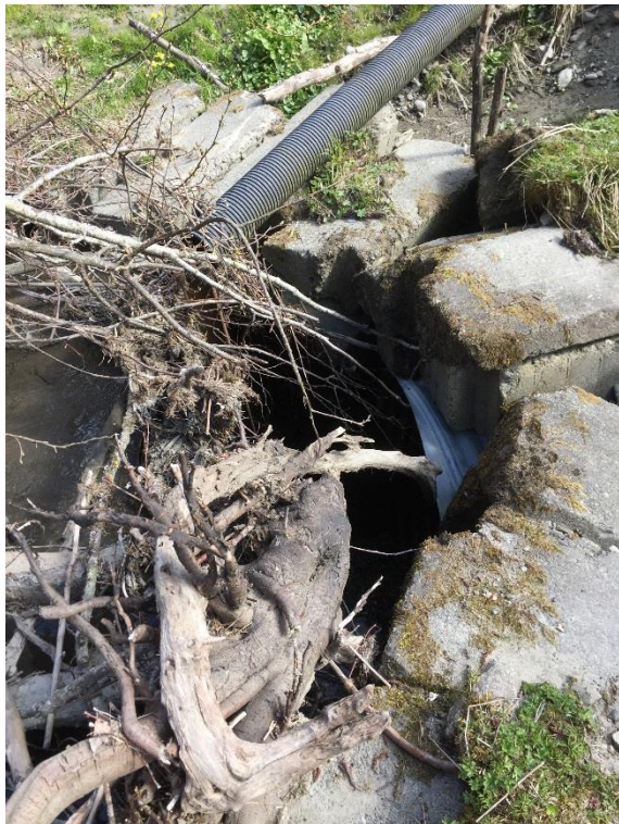
Bilde 254 og 260: Hhv utløp og innløp av rør. Innløpet er nærmest gjentettet av kvist og skrot og danner en terskel, med roligere strømningsforhold oppstrøms.
