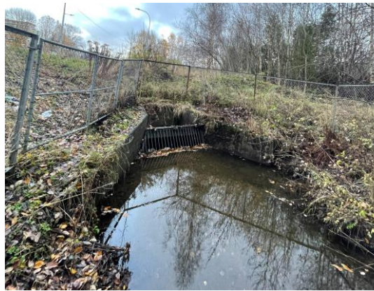
Figur 4: Bilde av innløpet til kulverten i punkt 2.
