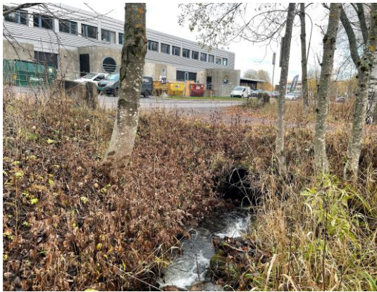
Figur 3: Bilde av innløpet til kulverten i punkt 1.
