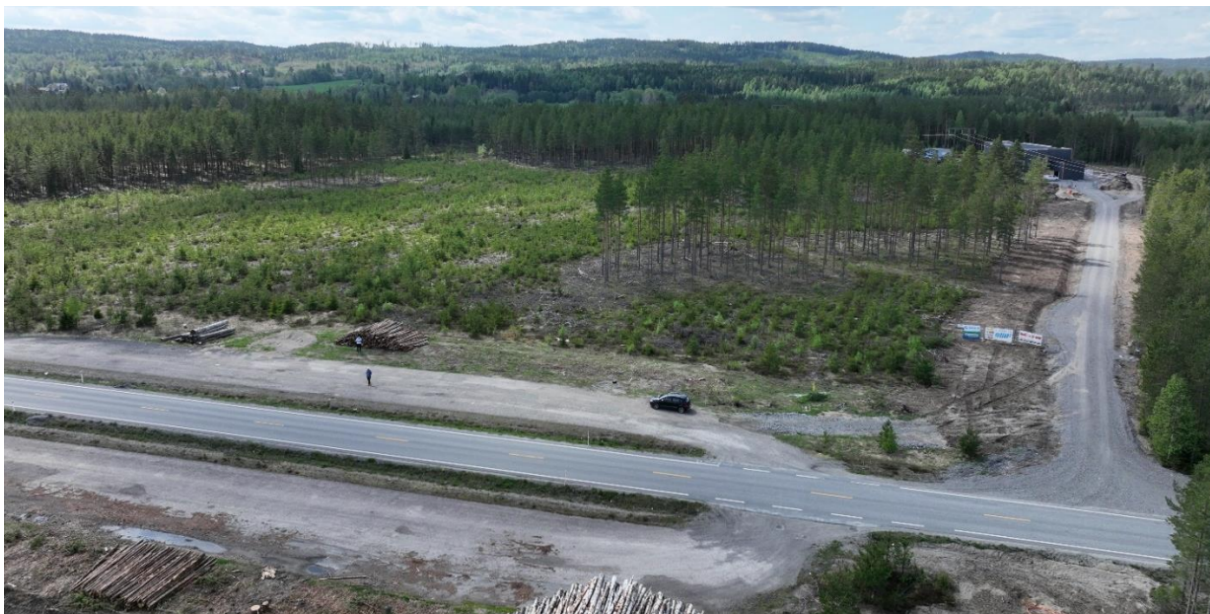
Figur 3 Oversiktsbilde av den sørvestlige delen av planområdet.
