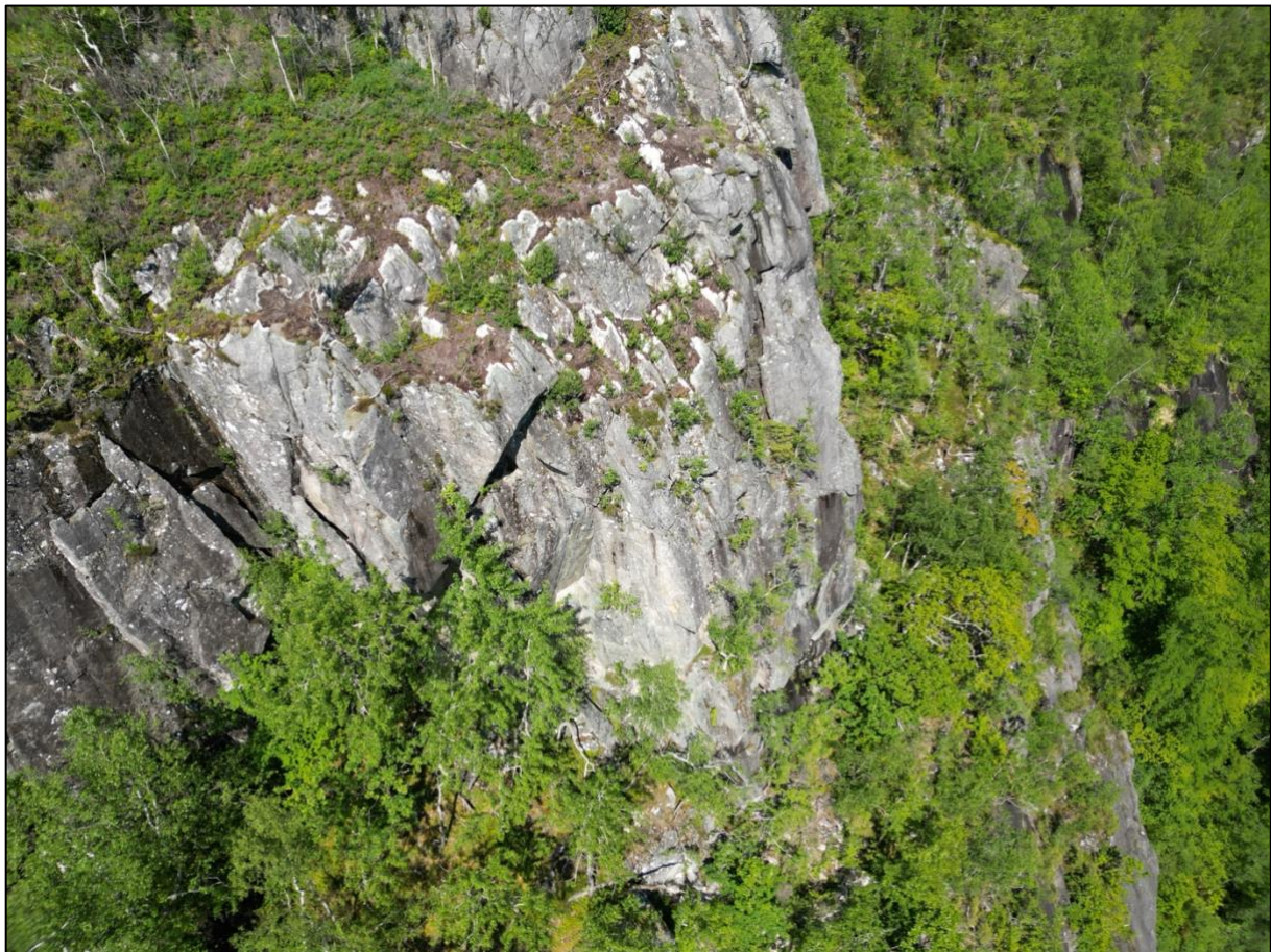
Figur 5: Dronebilde av skrentene ca. 250 moh., sett mot nordøst. Flere sprekkesett er synlige.
