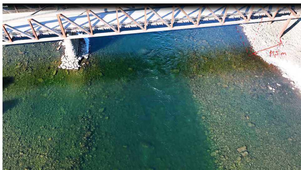
Figur 22. Drone bilde ved akse 2 og 3 fra Mars 2022 med ca. plassering av ny akse 3.
