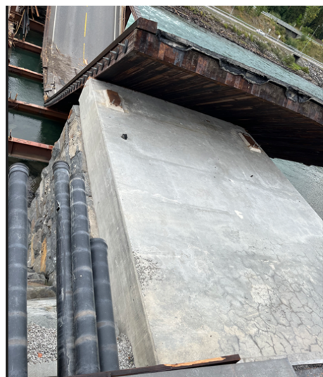
Figur 20. Eksisterende betongplate i akse 1.
