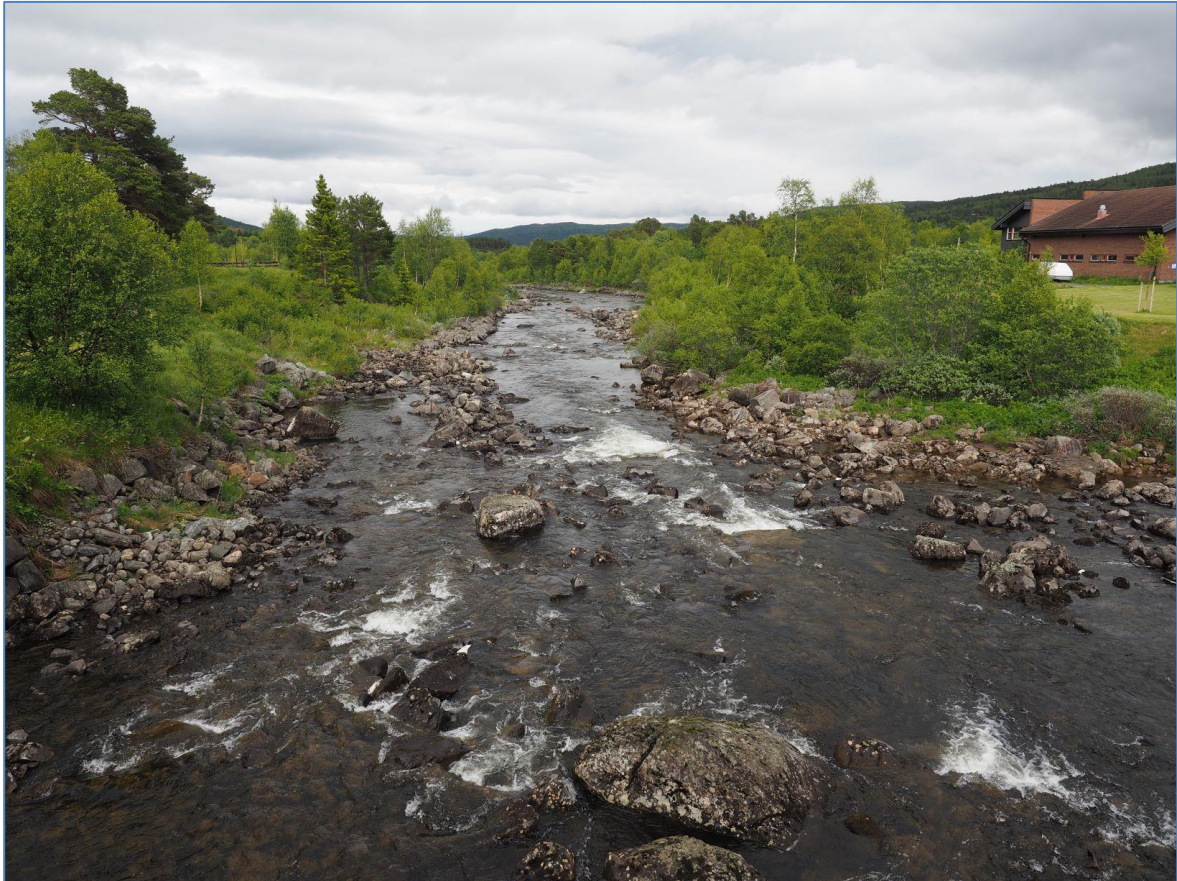
Figur 7a. Usteåne sett fra Geilo bru. Vannføringen er oppgitt til 1,1 m 3 /s (NVE 201700791-54).
