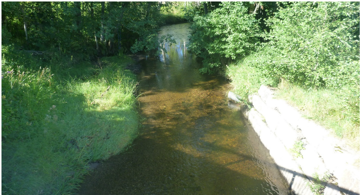
Figur 3-4. Elvebunnen ved Grobruelva.
