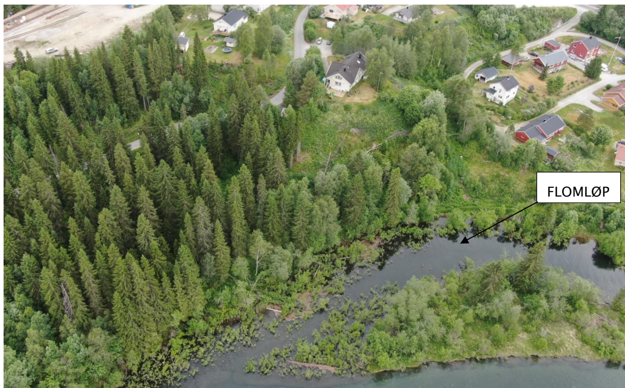
Bilde 3 – Området ved motfyllingen og flomløpet
