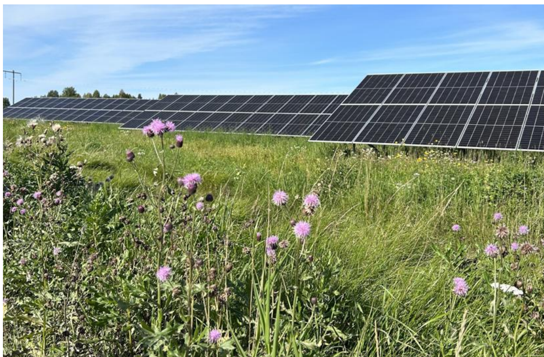
Figur 22 - Vegetasjon i solkraftverk sommeren etter bygging
