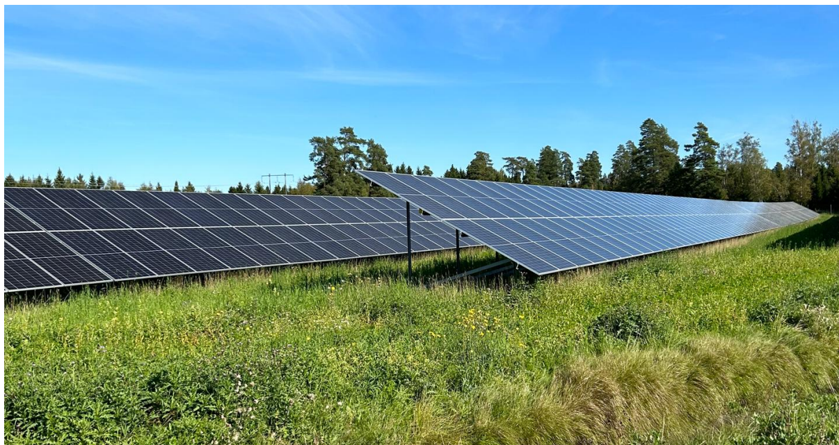
Figur 6 - Solcellepaneler montert i portrett
