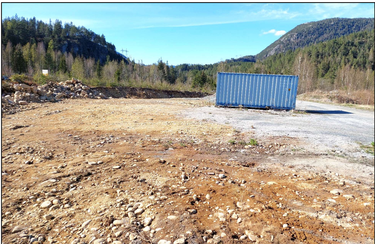
Figur 4: Bilde fra tenkt lokasjon av tiltaket.
