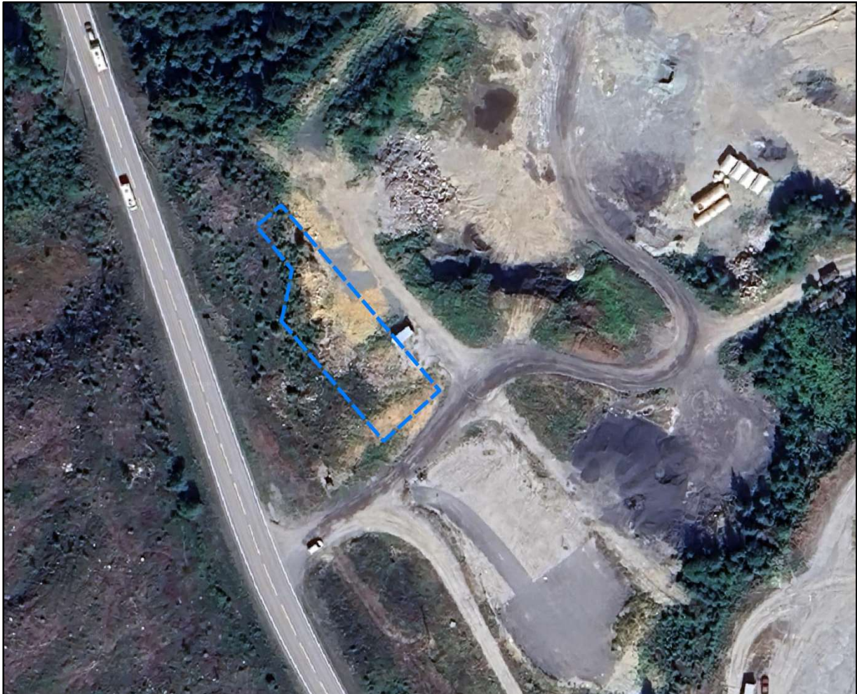
Figur 1: Stiplet avgrensning viser planområdet for Flå batteripark på gnr./bnr. 29/353, lokalisert innenfor Gulsvik sandtak i Flå kommune. Tiltaket er planlagt på et opparbeidet næringsareal i direkte nærhet til Flå transformatorstasjon.
