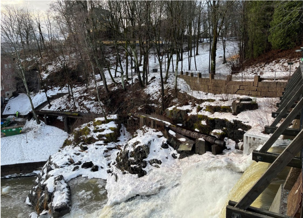
Figur 0-6 Vinterbilde av rørgata nedstrøms Fåbrofossen. Rørgata er nokså godt synlig i terrenget. Bildet er tatt fra dammen. Dammen skal erstattes av en ny dam
