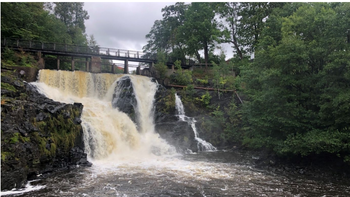
Figur 0-9 Sommerbilde av Fåbrofossen. Røret til høyre i bildet bør også fjernes.
