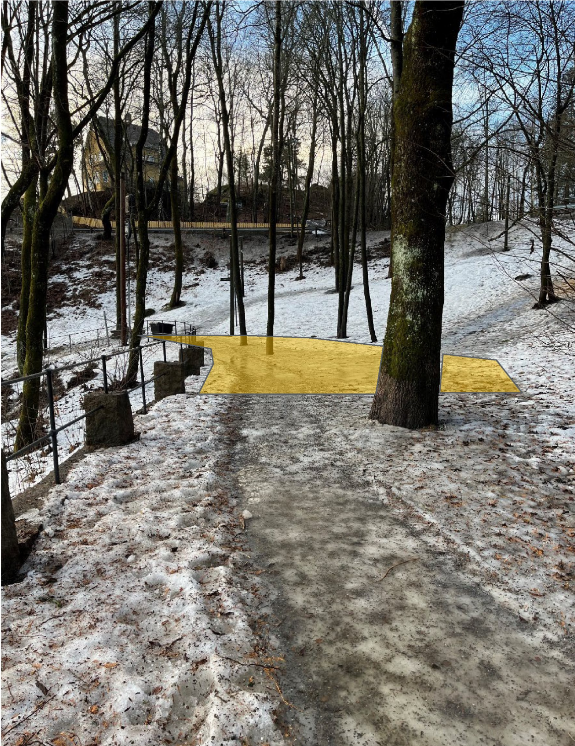
Figur 0-15 Det vil sannsynligvis være mulig å gjennomføre anleggsarbeidene med mobilkran uten å hugge trær i området. Det vil sannsynligvis ikke være mulig å kjøre helt bort til dammen med store maskiner pga. smal passasje mellom rekkverk og stort tre langs turveien. Omtrentlig plassering av riggareal på oversiden av rørgata er markert på bildet.
