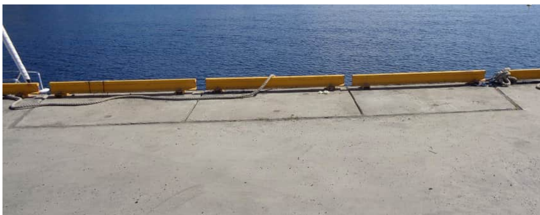
Figur 15 Bildeeksempel av betongblokker i kaihakk med påmontert kantlist
