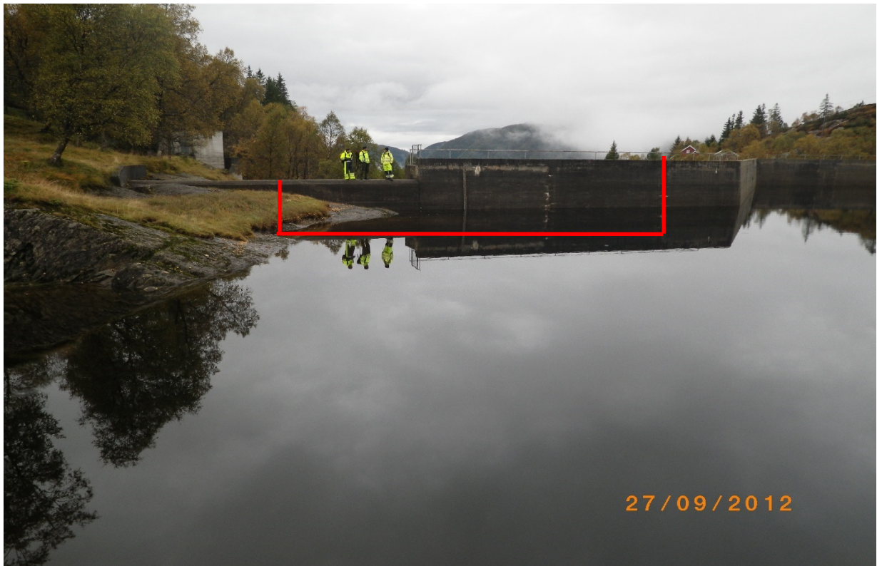
Bildet 3: Dam del mot sør sett fra magasinet . Venstre side av bildet viser dagens overløp . Rød merking viser plassering av planlagte nytt overløp. Terskel på nytt overløp vil være 387,50 moh , dagens HRV er 389,5 moh. Kote på vannspeilet i bildet er ca. 388.20 moh .
