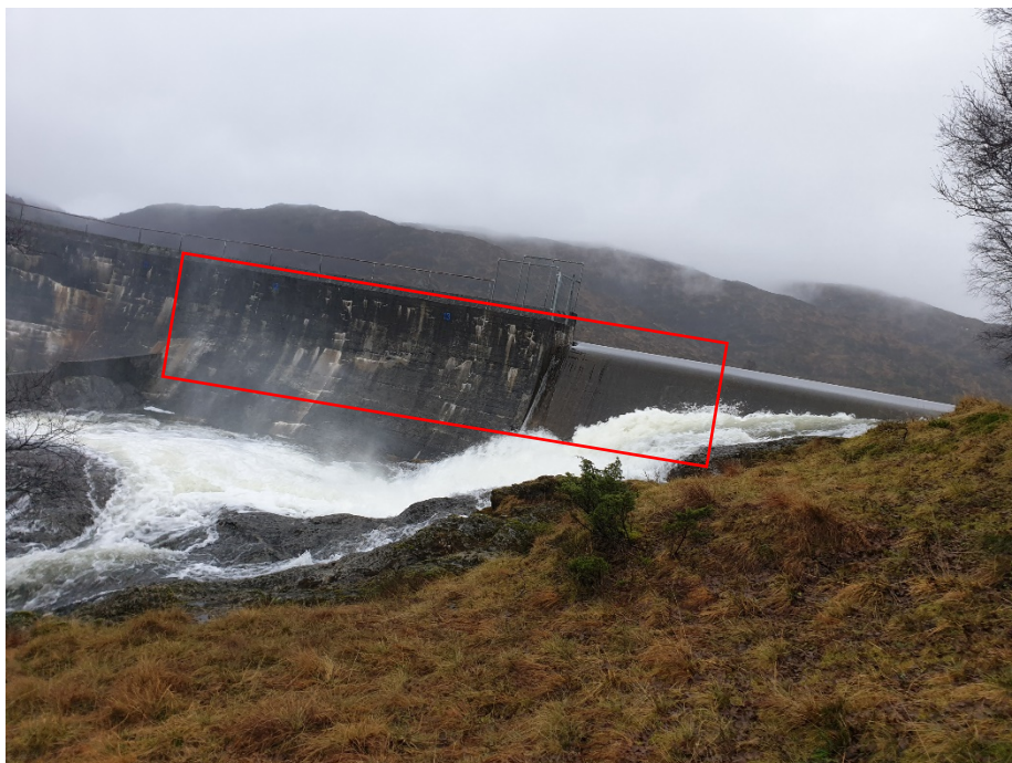
Bildet 2: Dam del mot sør sett fra nedstrøms dammen . Høyre side av bildet viser dages overløp i en liten flom. Rød firkant viser plassering av planlagte nytt overløp.
