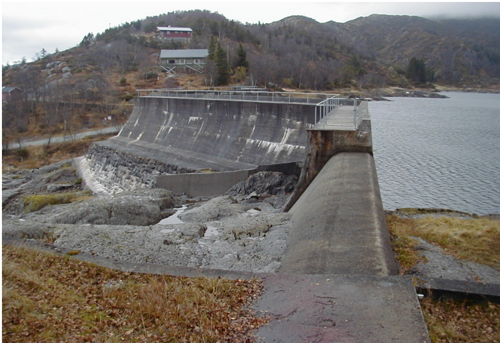
Bildet 5: dam men sett fra sør. Bildet viser bl.a. dagen s overløp.
