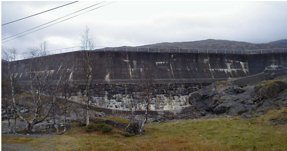
Bildet 4: Største damdel sett fra luftside .
