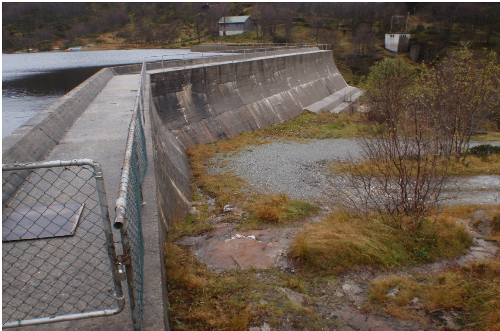
Bildet 6: dam men sett fra nord.
