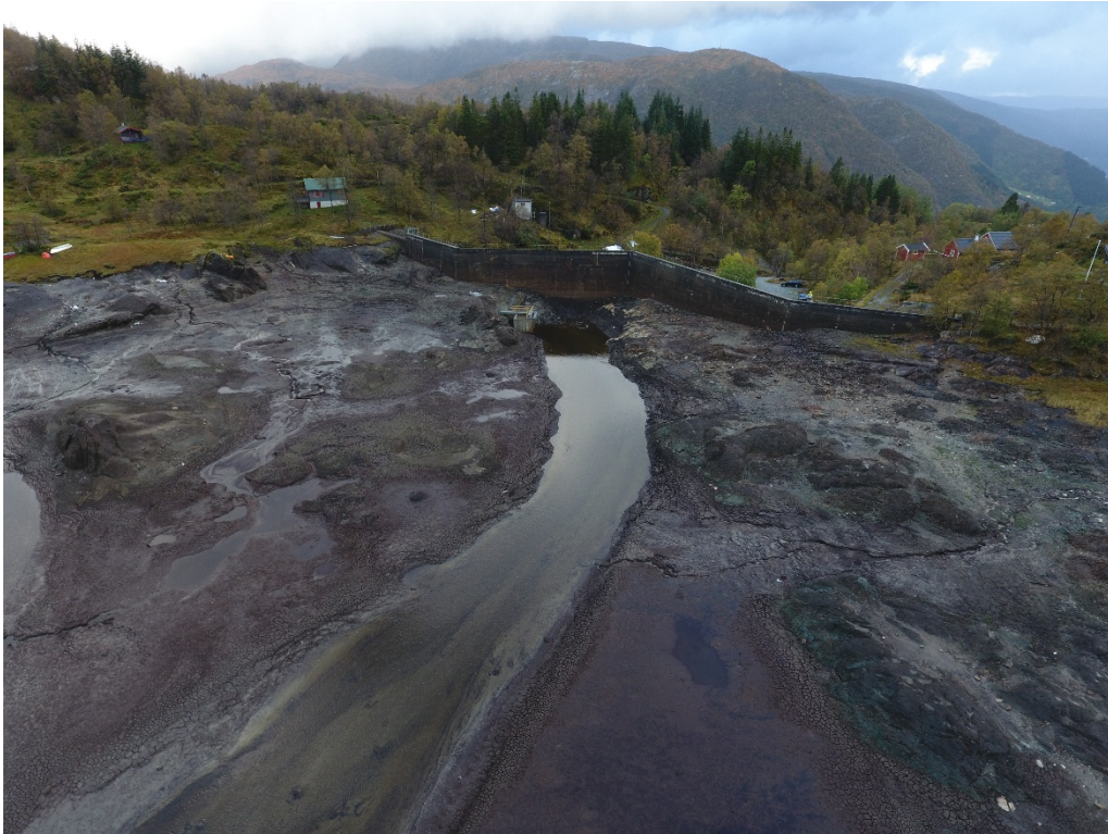
Bildet 1: Del av magasin areal mot dammen. Magasinkant på både høyre og venstre side viser vegetasjon under HRV .
