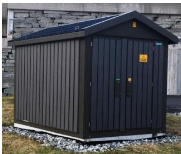
Figur 7: Ny omsøkt 22 kV Skagen nettstasjon
