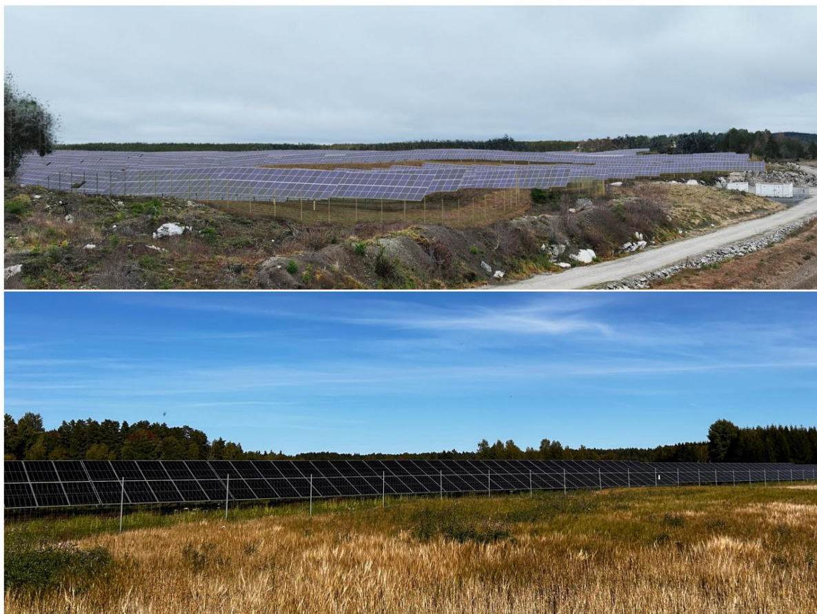
Figur 10 - Inngjerding av solkraftverk
