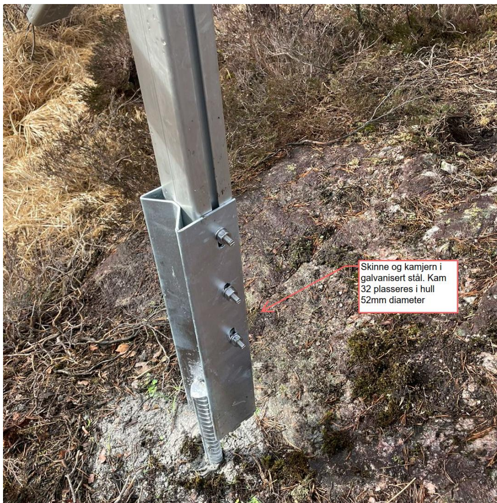
Figur 13: Fundamentering av solcellestativene på et prøvemontert stativ.
