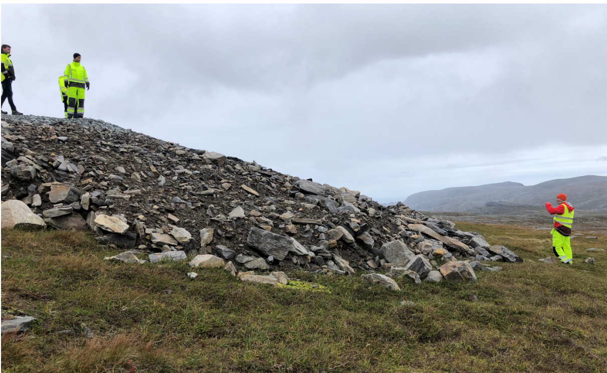
Figur 4: Eksempel på inngrep som må tilpasses omkringliggende terreng bedre. Større steiner kan fjernes fra foten av fyllingen, overgangen mot opprinnelig terreng kan jevnes ut. Foto: NVE.
