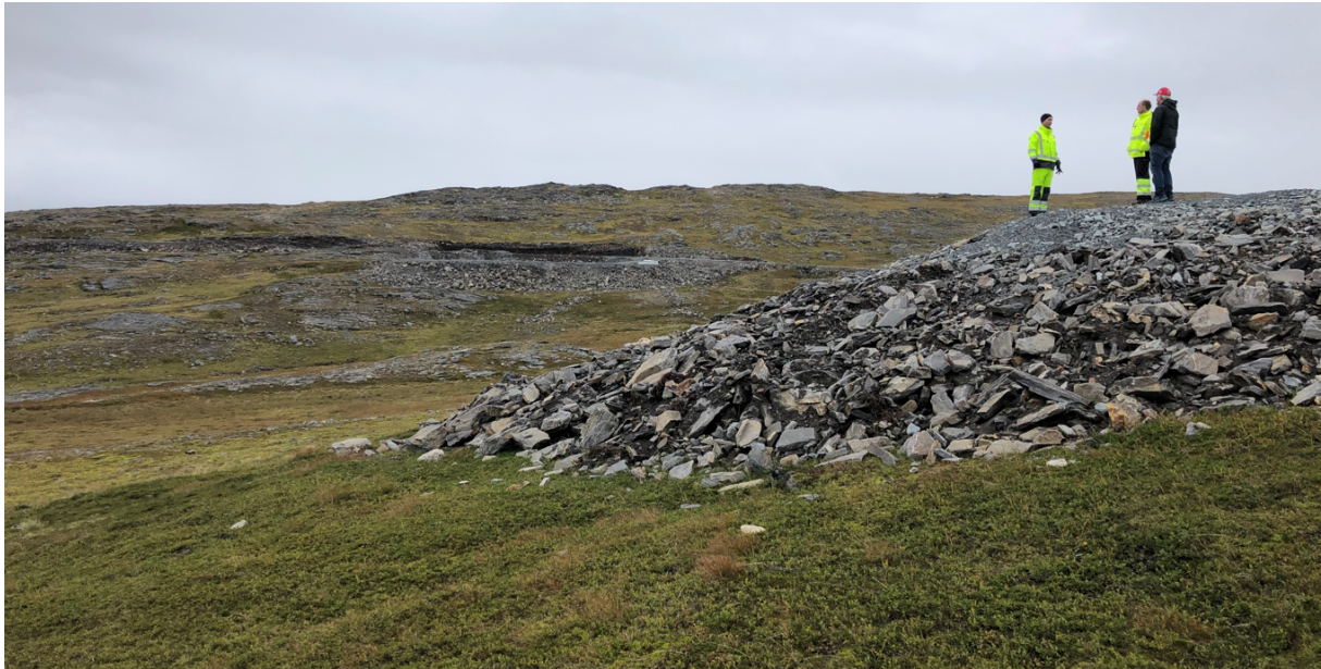
Figur 5: Eksempel på inngrep som kan tilpasses omkringliggende terreng bedre. Større steiner fjernes fra foten av fyllingen, overgangen mot opprinnelig terreng jevnes ut. Det er viktig at fyllingen forankres til terrenget. Foto: NVE.
