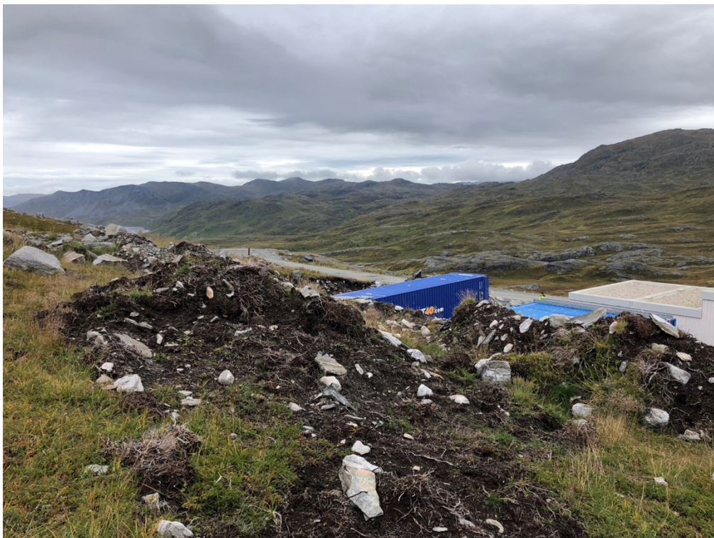
Figur 16: Bildet viser masser som er lagret/lagt til side i området nordvest for transformatorstasjonen. NVE mener vekstmassene kan skilles ut og brukes til istandsettingen. Foto: NVE.
