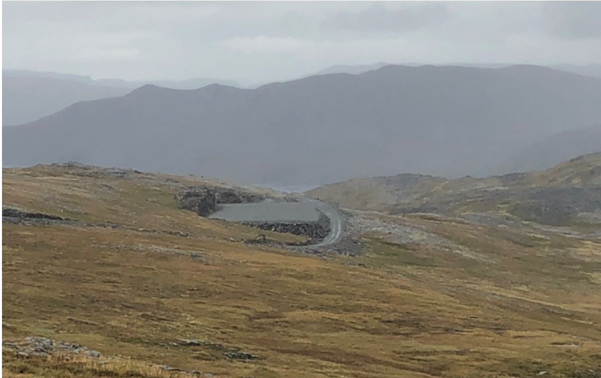
Figur 9: Riggplass/lagerområdet sett fra vest. Foto: NVE.
