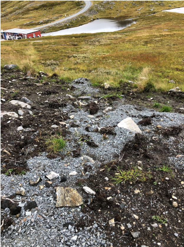
Figur 3: Eksempel på stein og grus som må ryddes opp. Det er også behov for arrondering av toppmassene mot sideliggende terreng for å få et tilfredsstillende sluttresultat. Foto: NVE.
