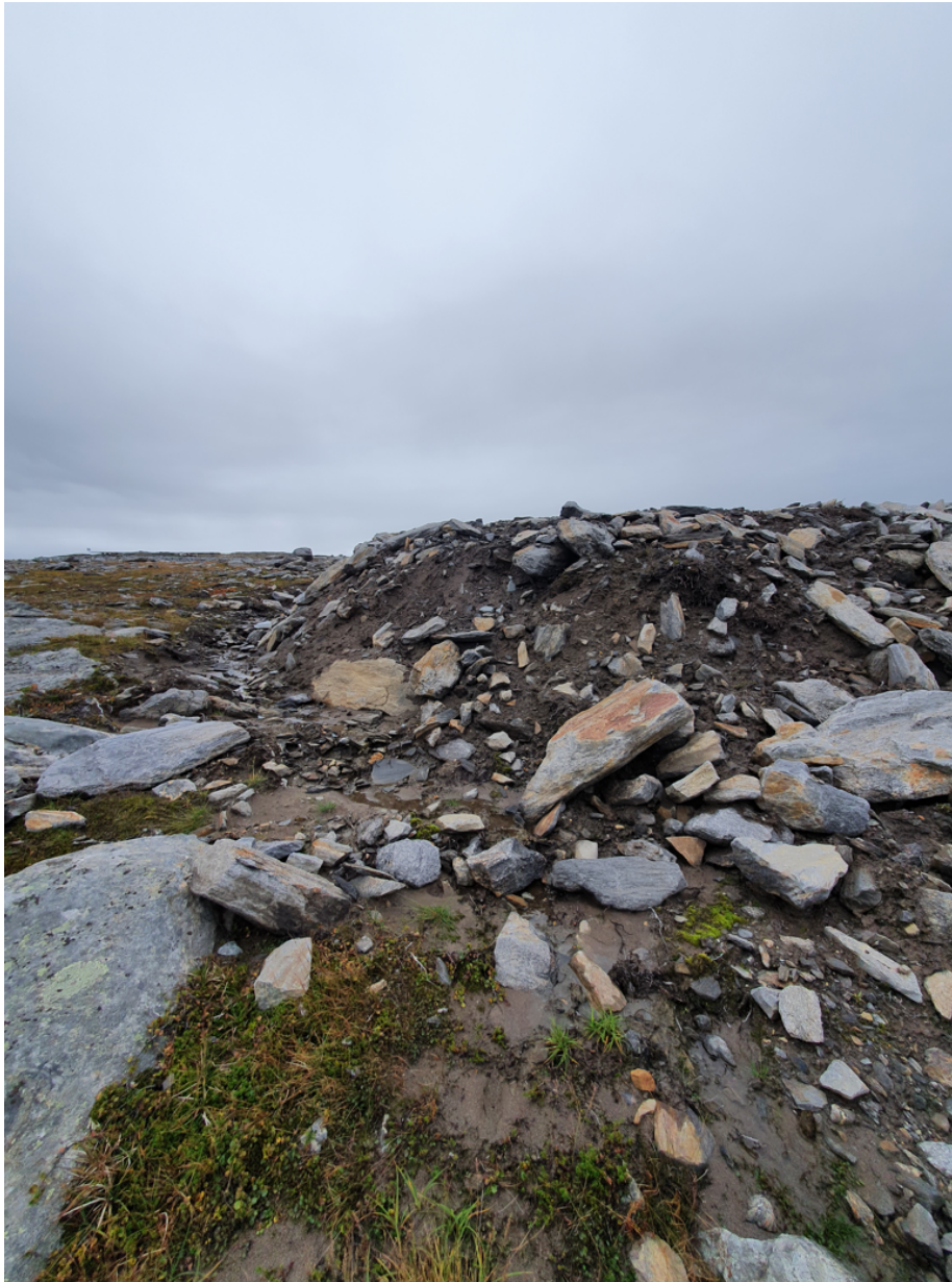
Figur 2: Eksempel på område hvor store stien må ryddes bort, og fyllingen kan formes til å forankres og tilpasses omkringliggende terreng bedre. Foto: NVE.
