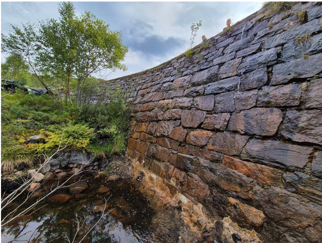
Figur 3. Bilde nedstrøms side Langevann
