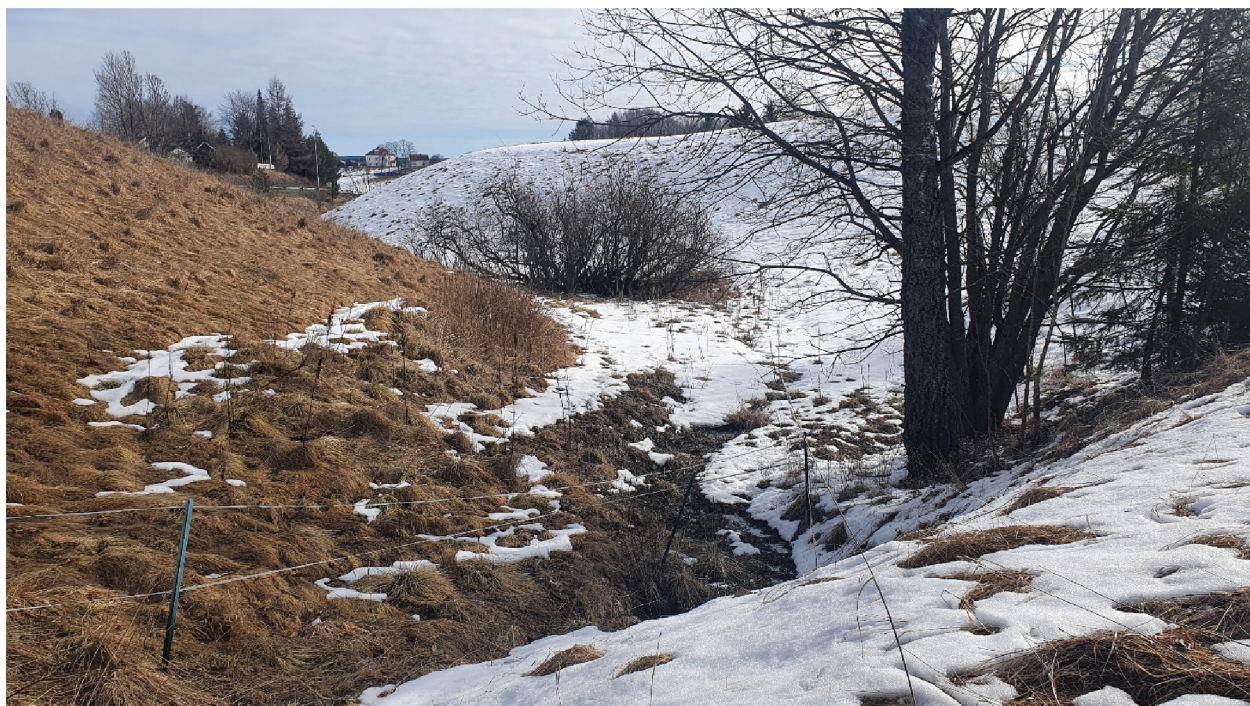
Figur 2.11 Ingen tegn til pågående erosjon som kan utløse skred er observert langs bekkedraget.
