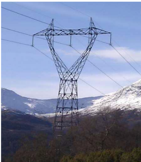
Figur 2-2 Tårnmast som vil bli benyttet på skredutsatt spenn til venstre og kabelnedføringsmast ved Illvatn pumpekraftverk til høyre.
