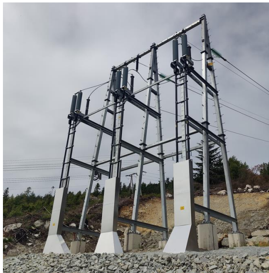
Figur 2-2 Tårnmast som vil bli benyttet på skredutsatt spenn til venstre og kabelnedføringsmast ved Illvatn pumpekraftverk til høyre.
