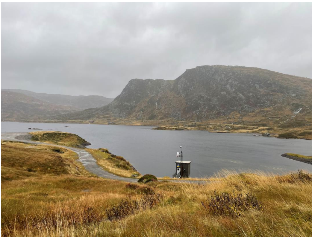
Figur 4-3: Bilde over Fossvatnet sett fra øst med lukehus midt i bildet. Eksisterende riggplass er synlig til venstre i bildet. Foto: COWI AS
