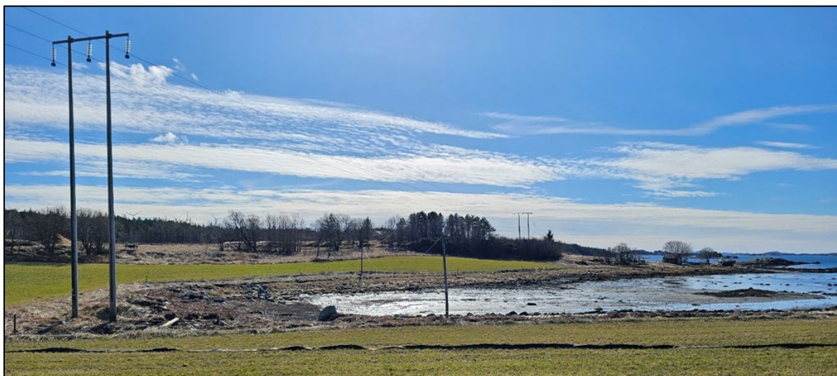
Figur 13: Bilder fra Yttersjøen der sanering av eksisterende 66 kV ledning, som ligger i den eksponerte sårbare strandsona, vil være positivt for landskapsbildet. Ny ledning vil krysse over jordene lengre inne (Foto: Hilde Bruheim Johnsborg, Multiconsult).
